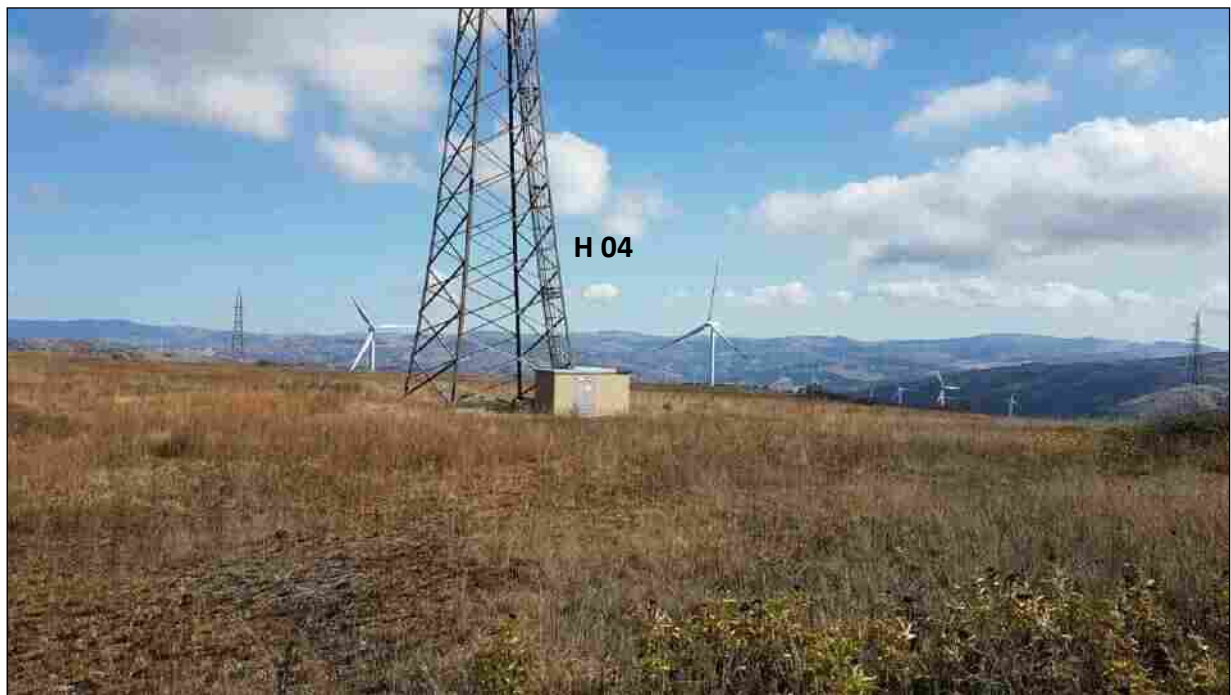
Foto 15 – Area basale della turbina H 04 da dismettere (Comune di Molinara)
