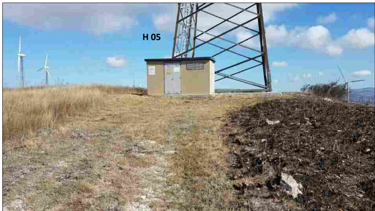
Foto 16 – Area basale della turbina H 05 da dismettere (Comune di Molinara)
