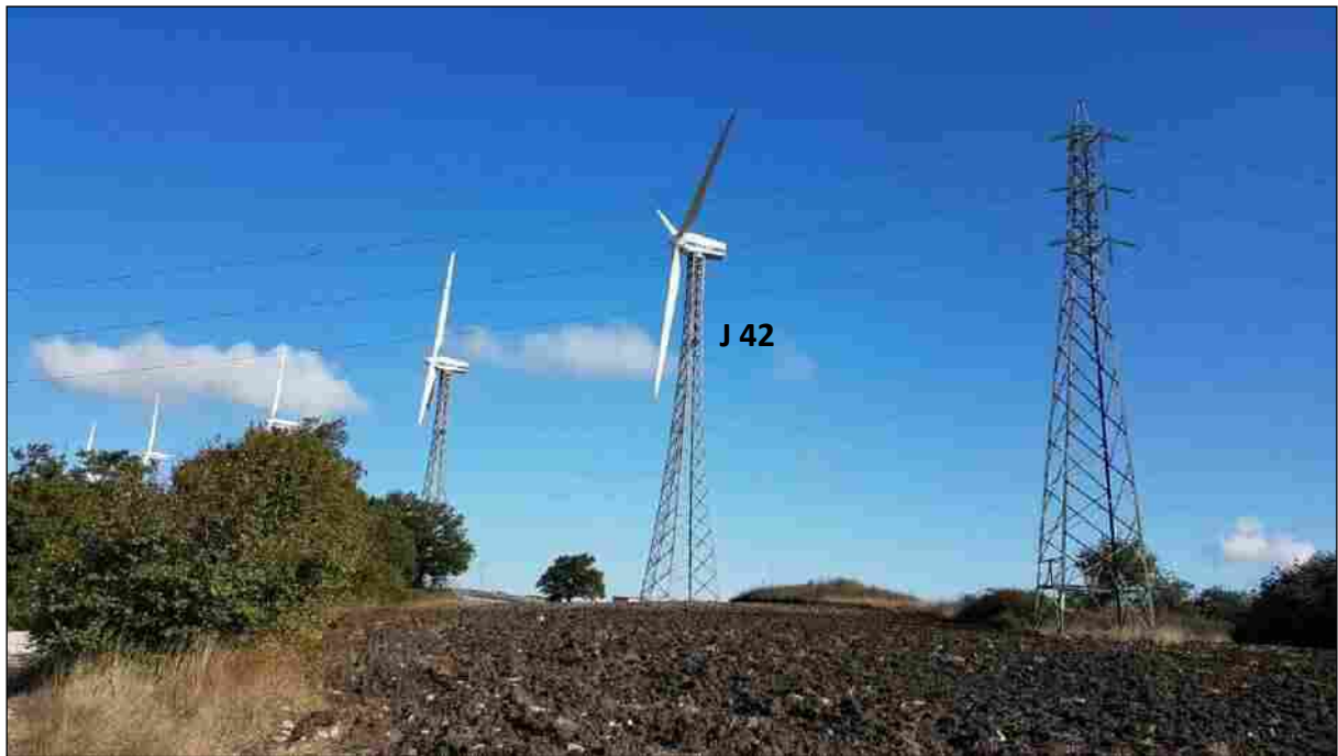
Foto 9 – Turbina J 42 da dismettere (Comune di Molinara)
