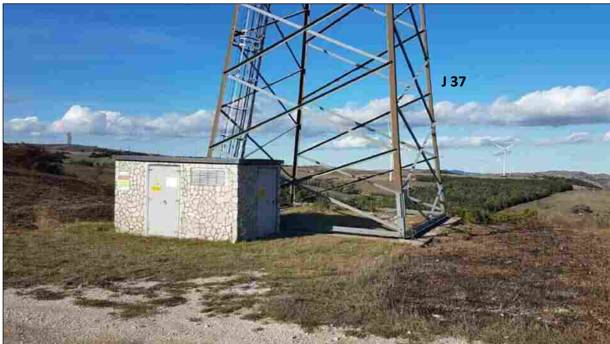
Foto 5 - Turbina J 37 da dismettere (Comune di Molinara)
