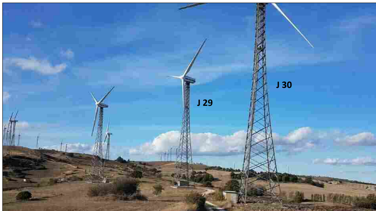
Foto 1 - Turbina J 29 e turbina J 30 da dismettere (Comune di Molinara)
