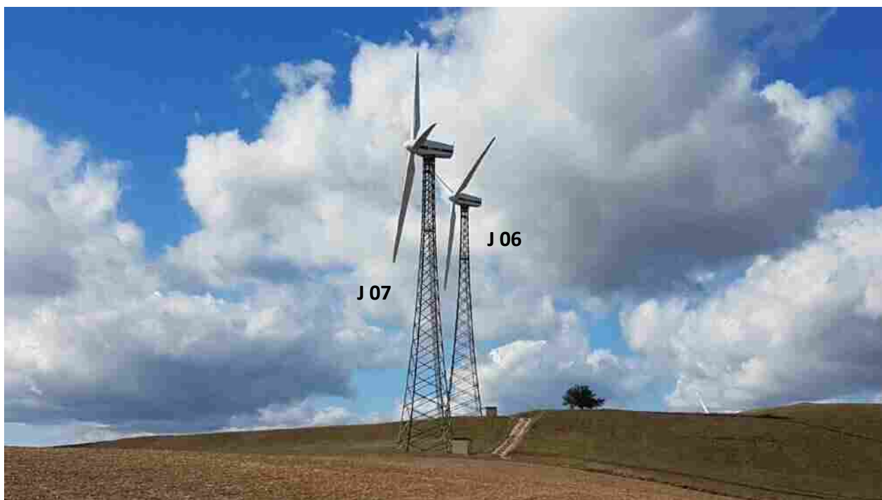
Foto 3 - Turbina J 07 e turbina J 06 , da dismettere (Comune di Baselice)
