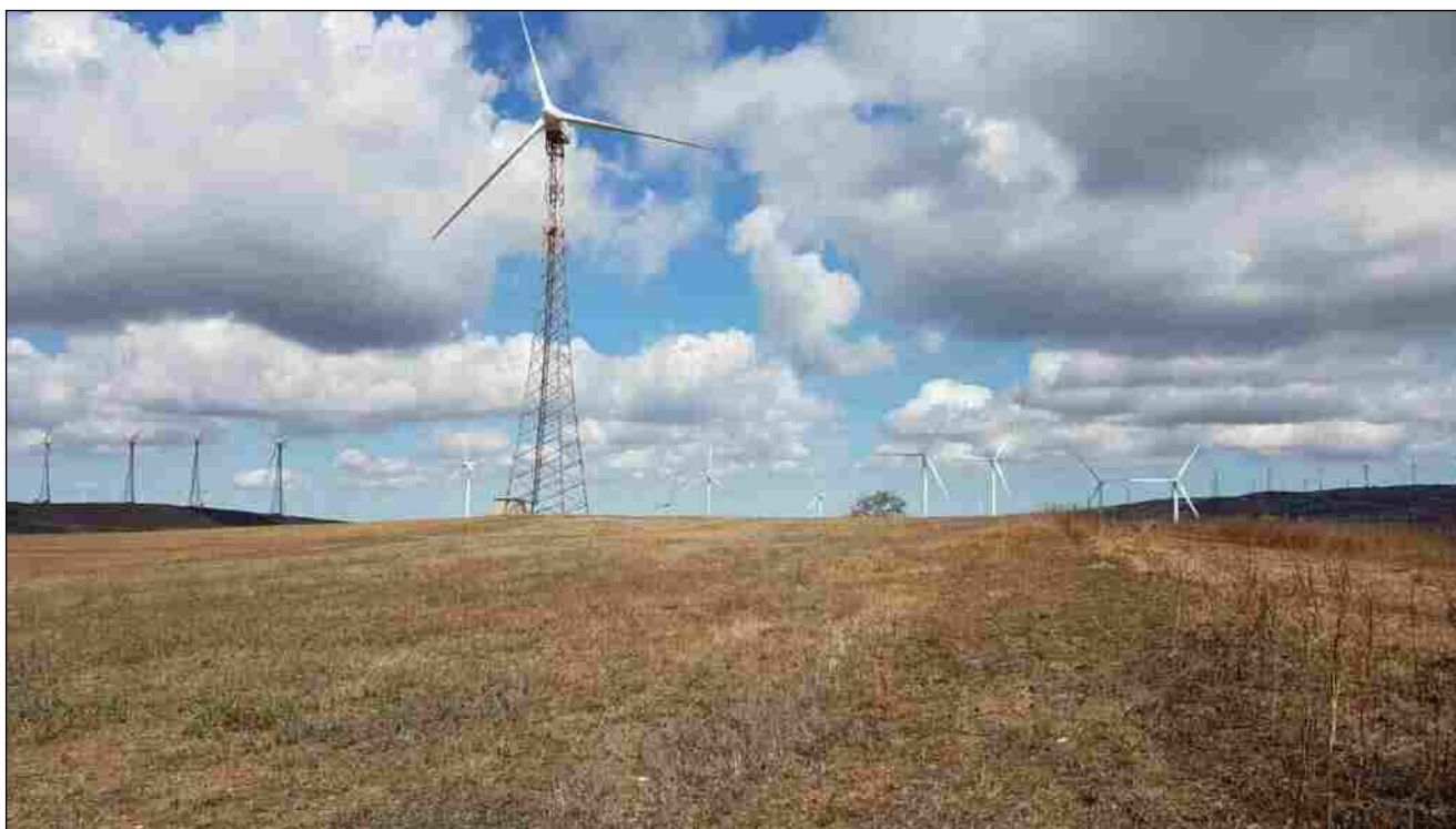
Foto 26 – Area di seminativo, interessata dall'aerogeneratore SGM 05 in progetto; al centro della foto, l'aerogeneratore H 20 da dismettere
