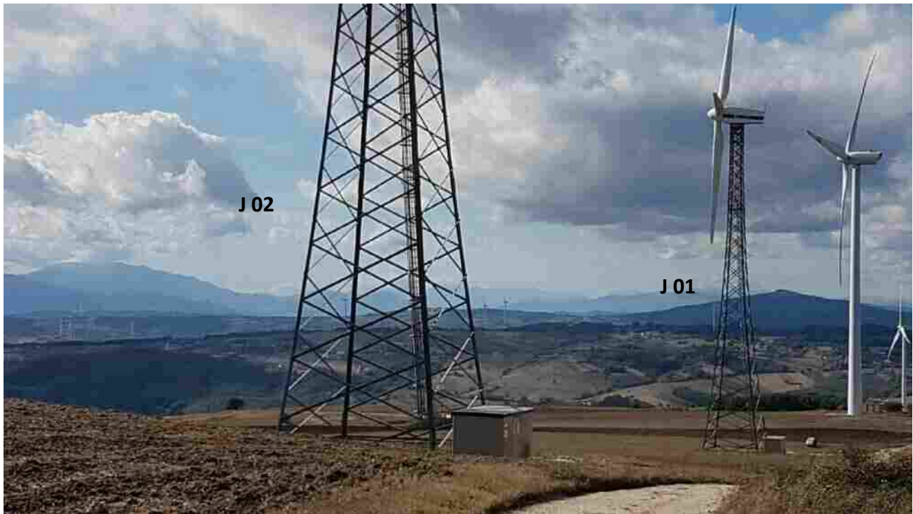
Foto 1 - Turbina J 02 e turbina J 01 da dismettere (Comune di Baselice)
