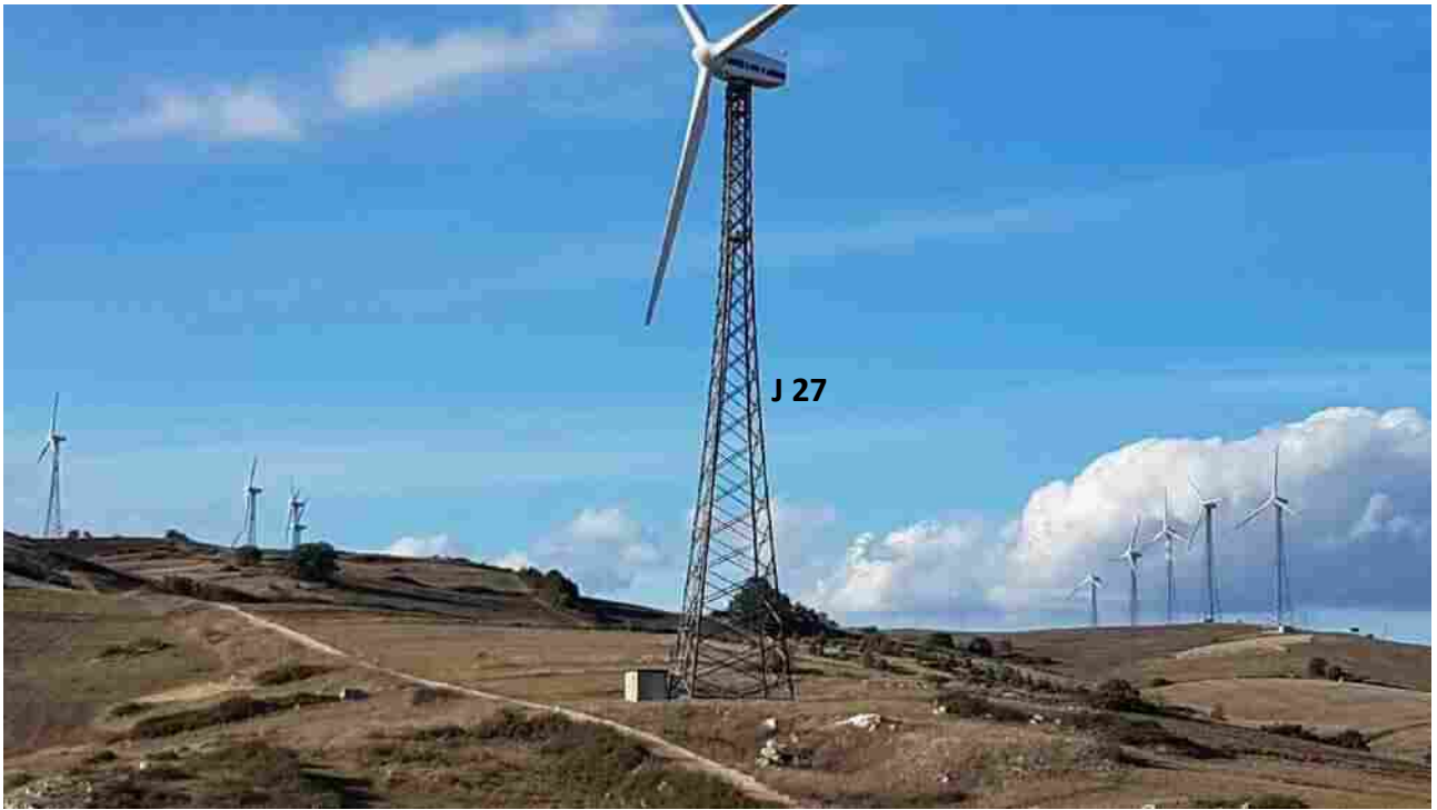
Foto 13 – Turbina J 27 da dismettere (Comune di San Marco dei Cavoti)
