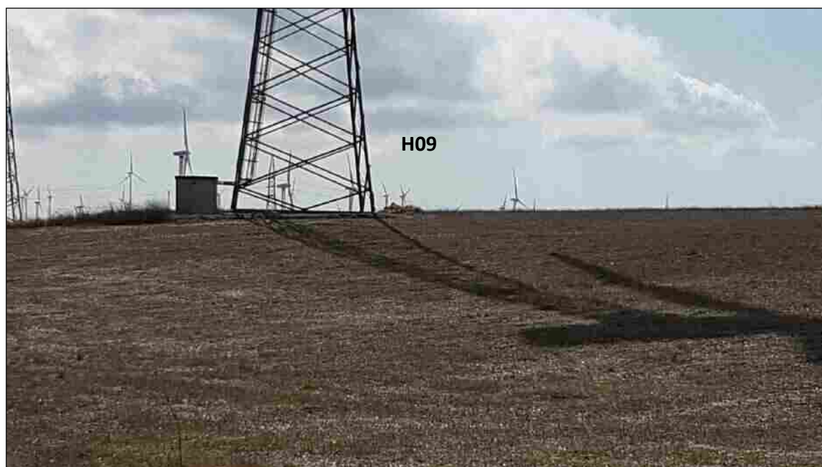
Foto 2 – particolare dell'area basale della Turbina H 09 da dismettere (Comune di San Giorgio la Molara)
