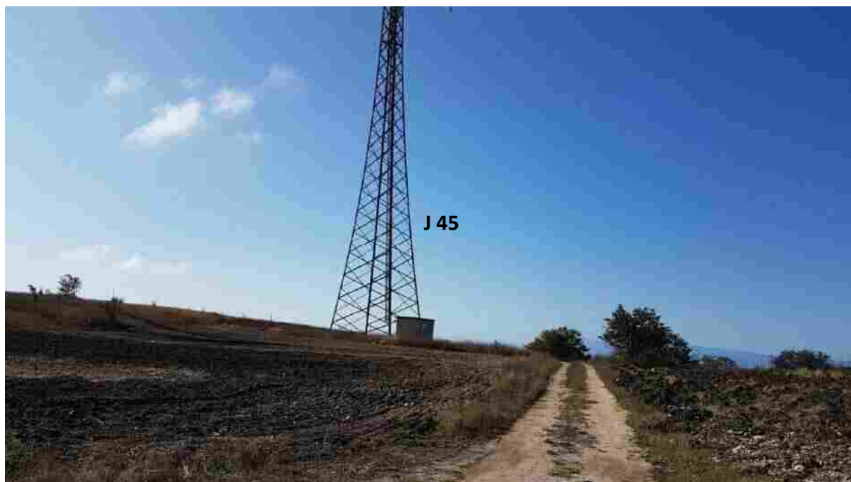
Foto 12 – Turbina J 45 da dismettere (Comune di Molinara)
