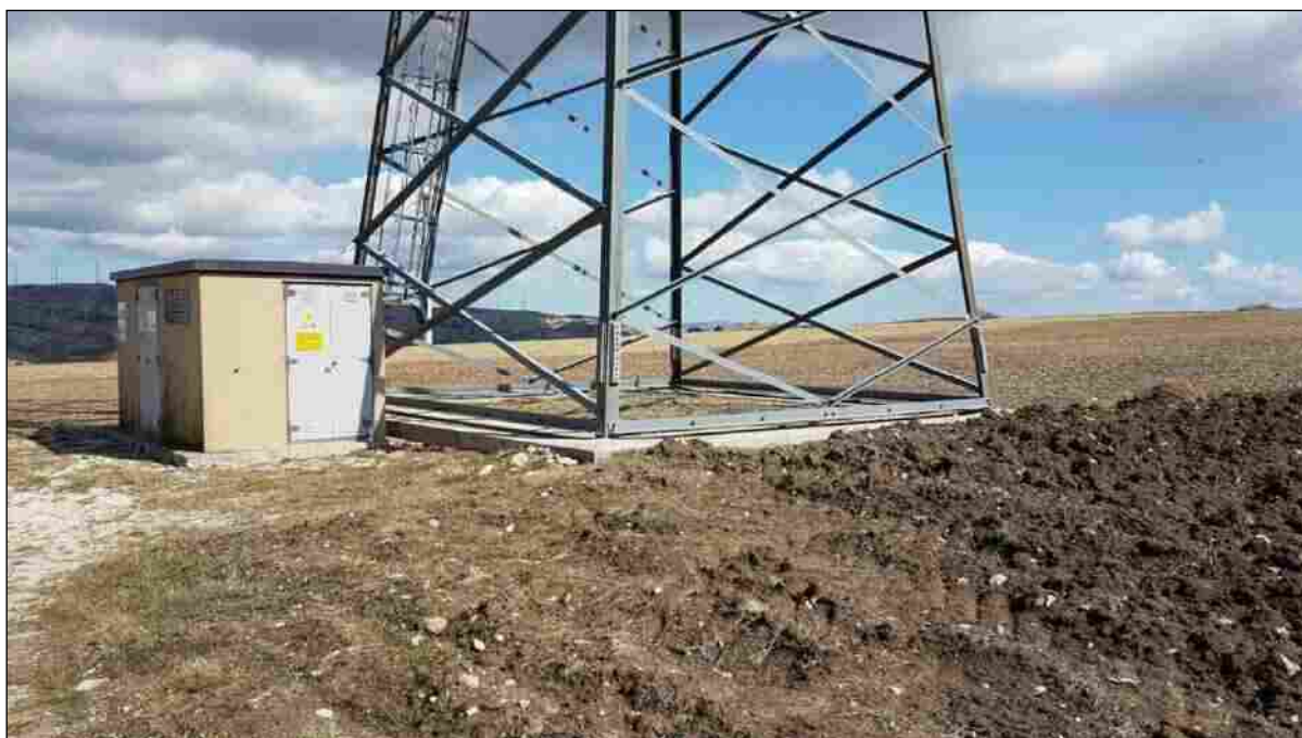
Foto 11 – Particolare dell'area basale della turbina H 23 da dismettere (Comune di San Giorgio la Molara)
