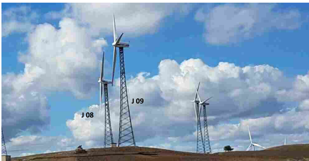
Foto 4 - Turbina J 08 e turbina J 09 , da dismettere (Comune di Baselice); a destra le turbine J07 e J06 della foto 3
