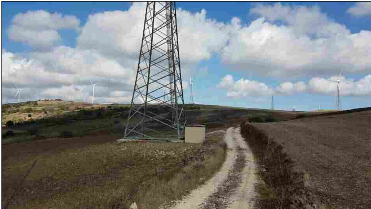
Foto 16 – Turbina I. 01 da dismettere (Comune di San Giorgio la Molara)
