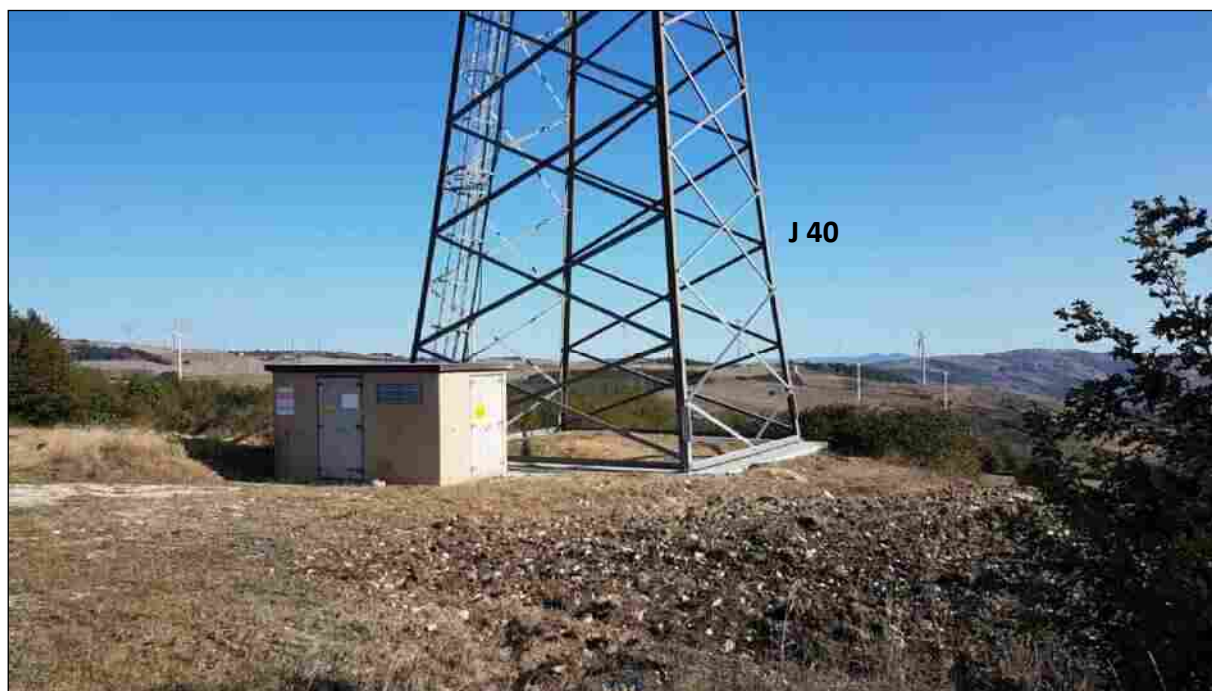
Foto 7 – Turbina J 40 da dismettere (Comune di Molinara)
