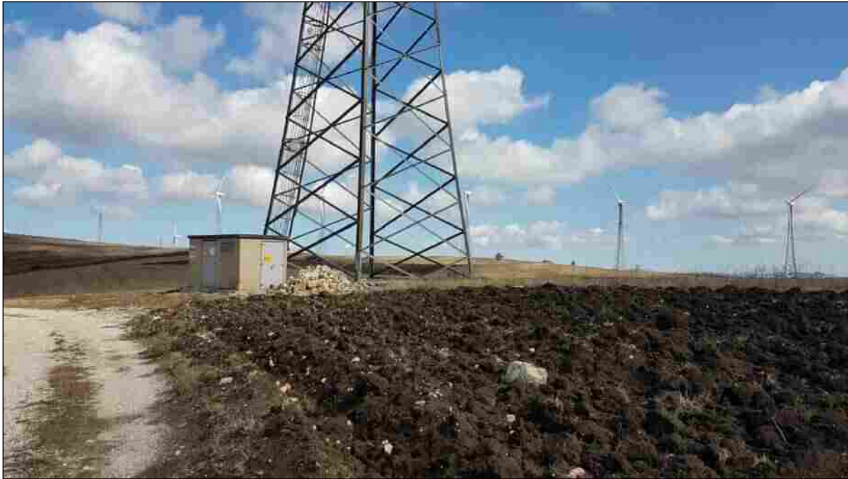
Foto 17 – Turbina I 02 da dismettere (Comune di San Giorgio la Molara)
