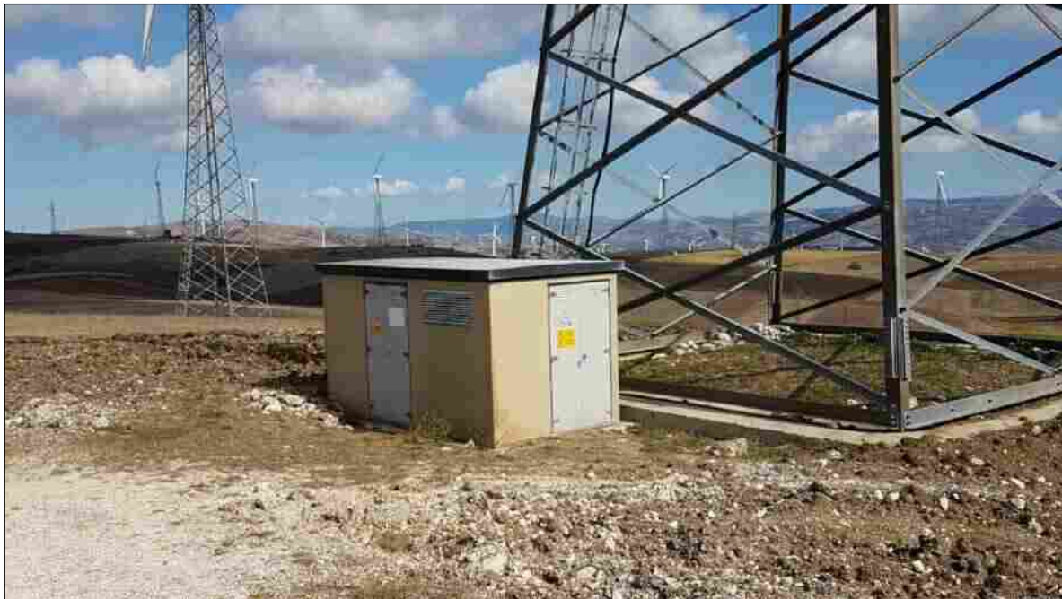
Foto 19 – particolare dell'area basale della Turbina I 05 da dismettere (Comune di San Giorgio la Molarà)
