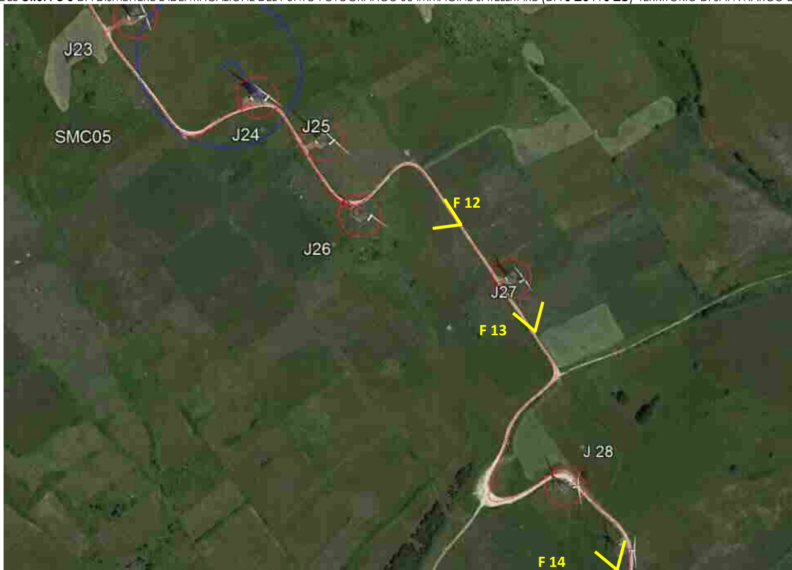
TURBINE DEL GRUPPO J DA DISMETTERE E IDENTIFICAZIONE DEL PUNTO FOTOGRAFICO SU IMMAGINE SATELLITARE (DA J 26 A J 28 )-TERRITORIO DI SAN MARCO DEI CAVOTI
