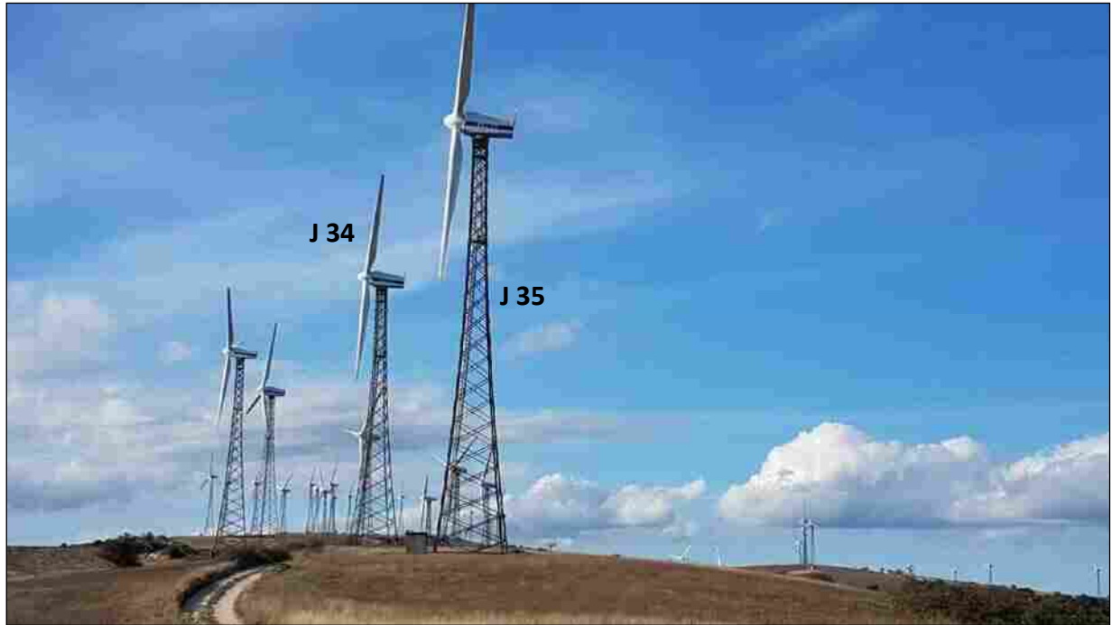
Foto 3 - Turbina J 34 e turbina J 35 , da dismettere (Comune di Molinara)
