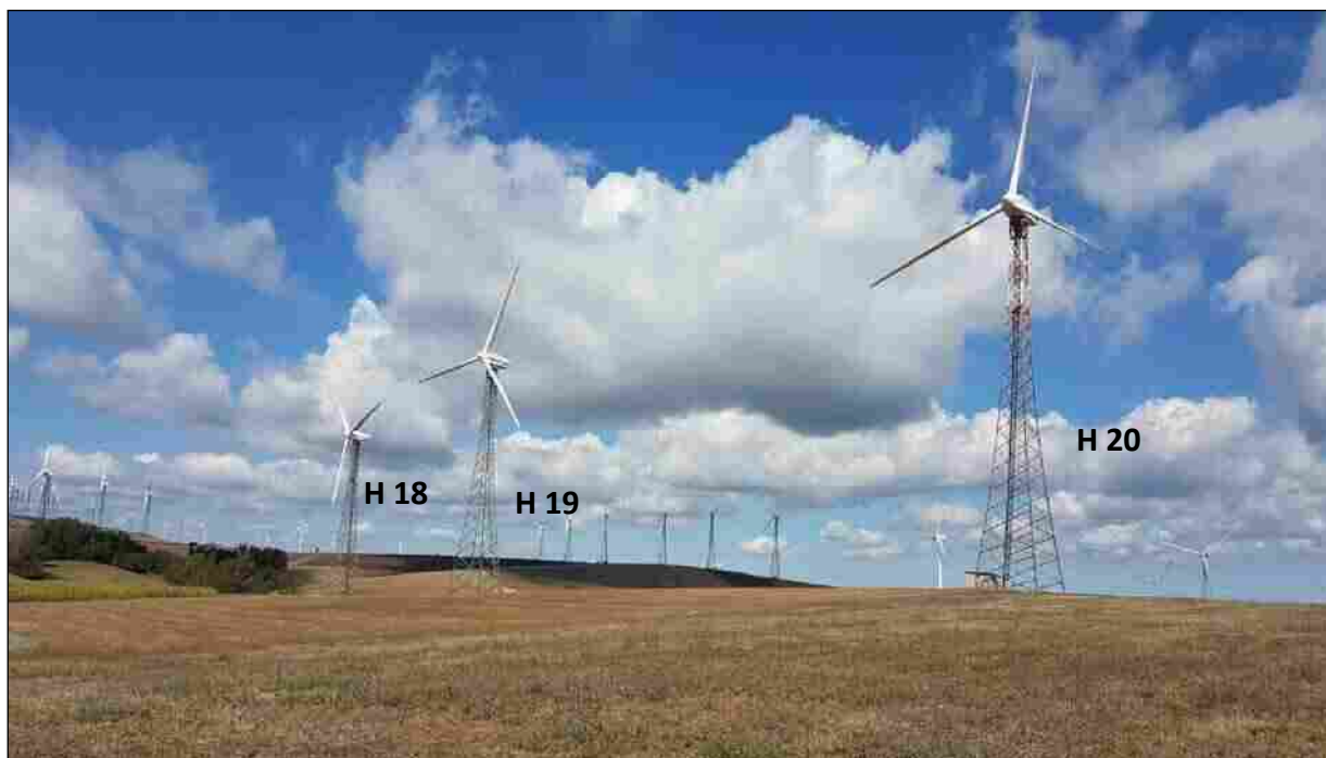
Foto 09 – Turbine H 18 , H 19 , H 20 , da dismettere (Comune di San Giorgio la Molara)
