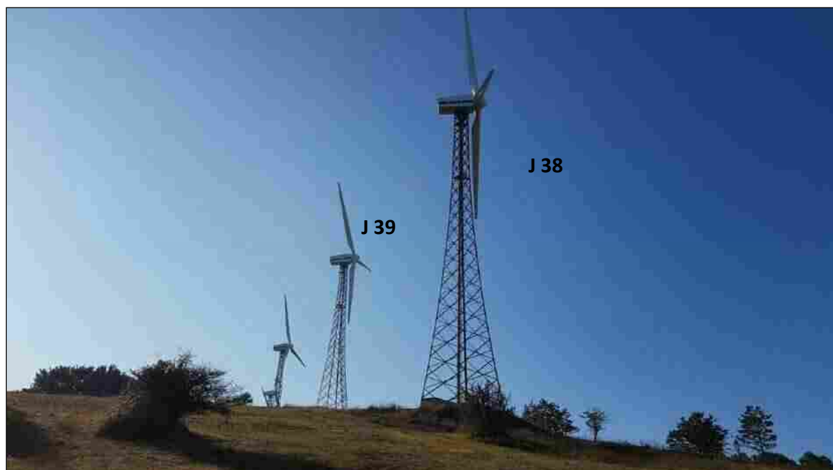
Foto 6 – Turbina J 38 e turbina J 39 , da dismettere (Comune di Molinara)
