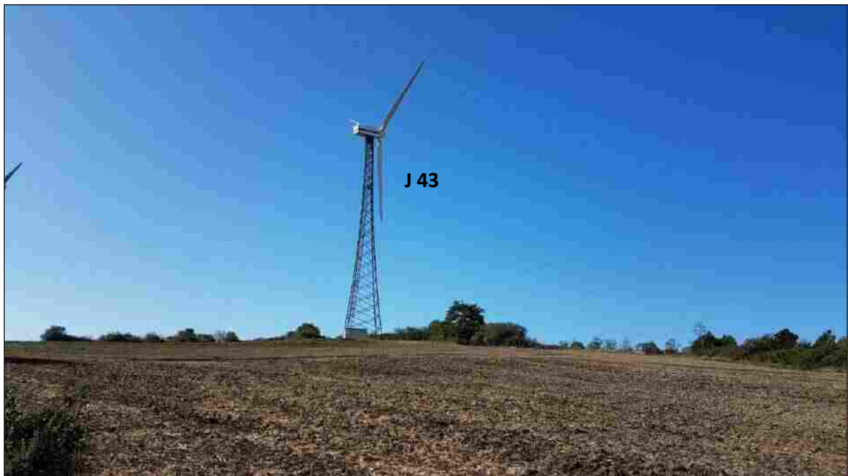
Foto 10 – Turbina J 43 da dismettere (Comune di Molinara)
