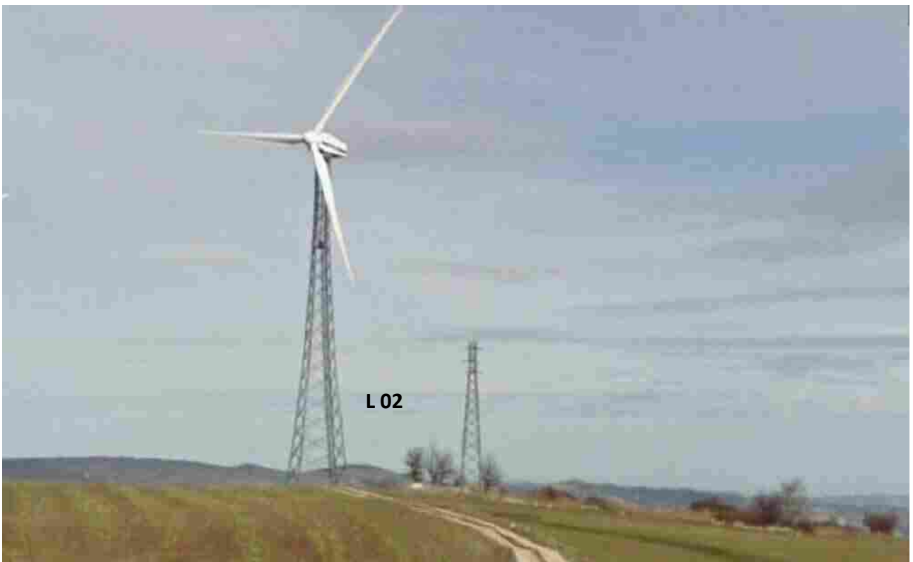
Foto 6 – Turbina L 02 da dismettere (Comune di Baselice)
