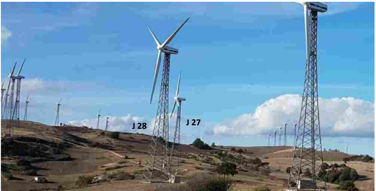
Foto 14 – Turbine J 28 e J 27 da dismettere (Comune di San Marco dei Cavoti)
