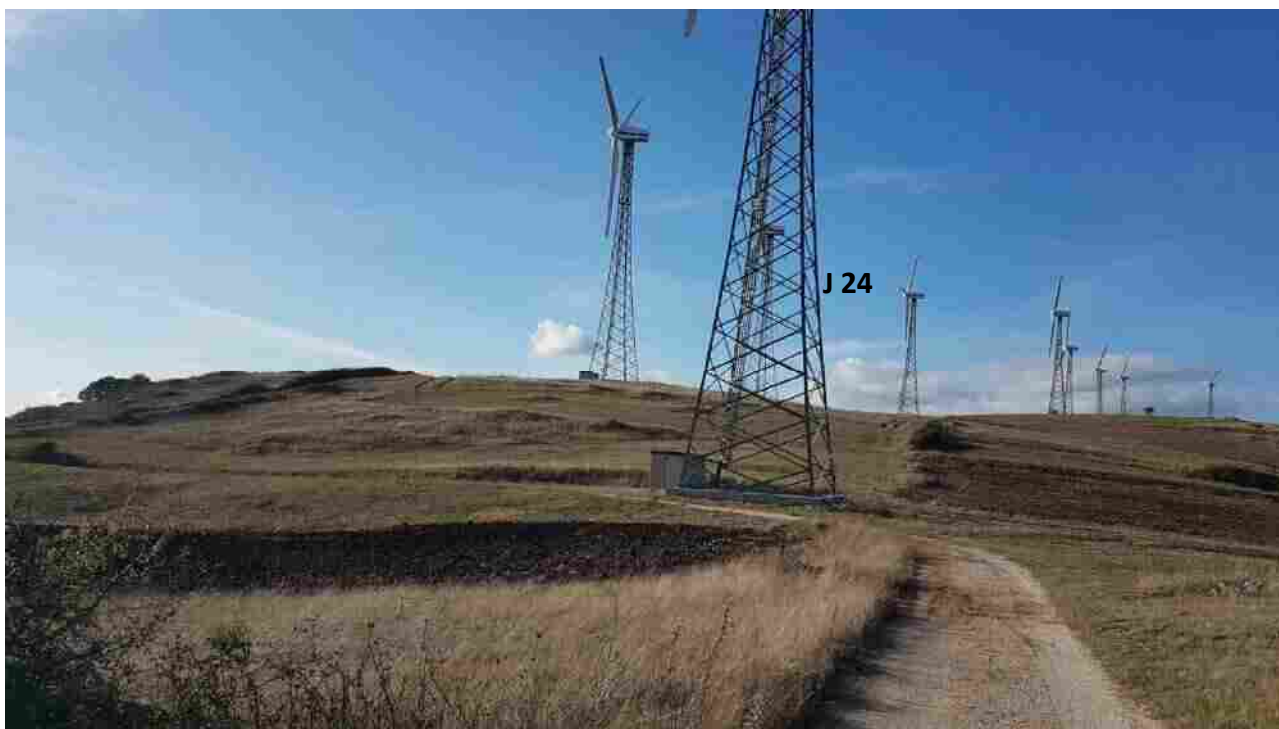
Foto 10 – Turbina J 24 da dismettere (Comune di San Marco dei Cavoti)
