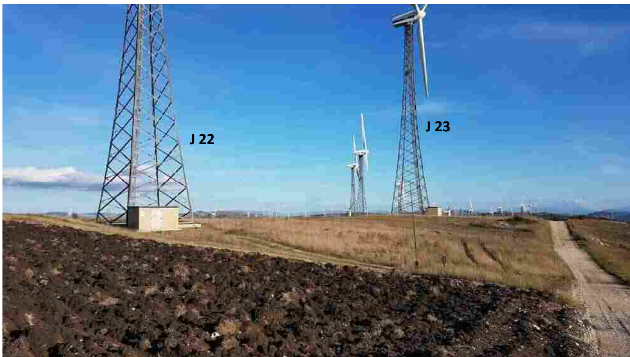
Foto 9 – Turbina J 22 e turbina J 23 da dismettere (Comune di San Marco dei Cavoti)
