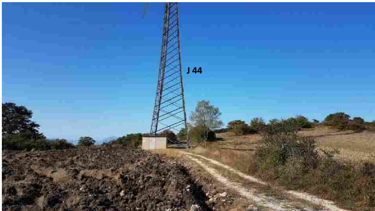
Foto 11 – Turbina J 44 da dismettere (Comune di Molinara)
