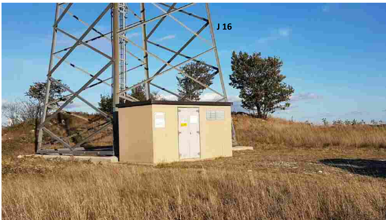
Foto 5 - settore basale Turbina J 16 da dismettere (Comune di San Marco dei Cavoti)
