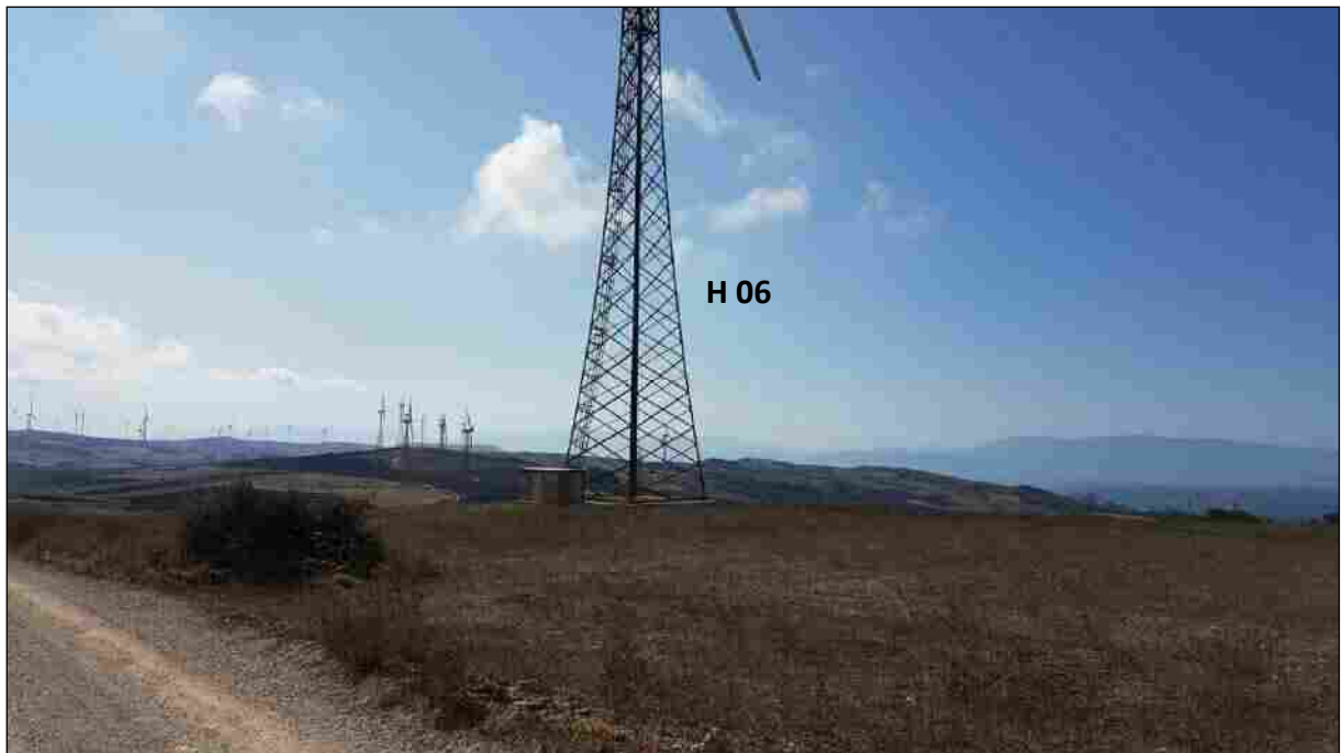
Foto 17 – Turbina H 06 da dismettere (Comune di Molinara)
