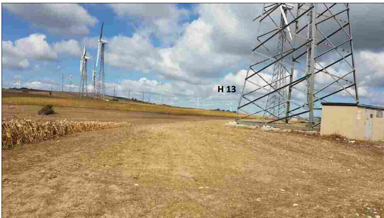
Foto 5 – Particolare dell'area basale della Turbina H 13 da dismettere(Comune di San Giorgio la Molara)
