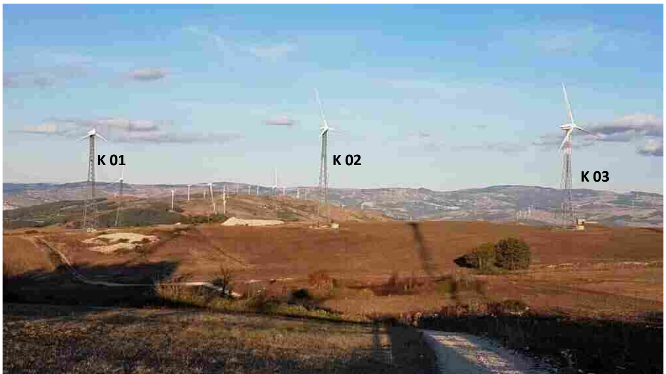
Foto 11 – Vista verso est, delle turbine K 01 , K 02 , K 03 da dismettere (Comune di Foiano di Val Fortore)
