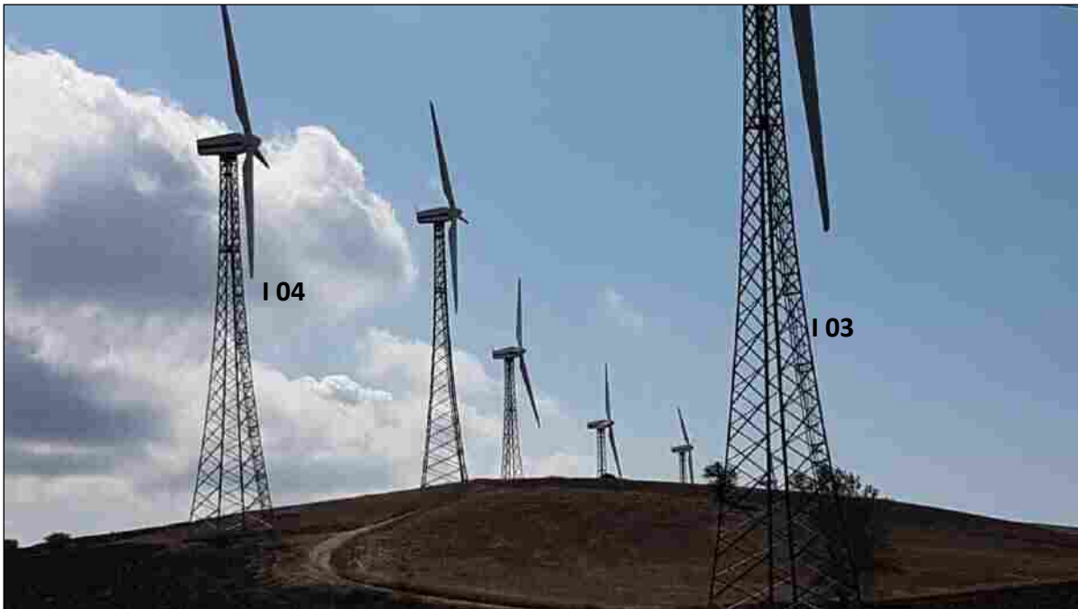
Foto 18 – Turbina I 03 e turbina I 04 da dismettere (Comune di San Giorgio la Molara)
