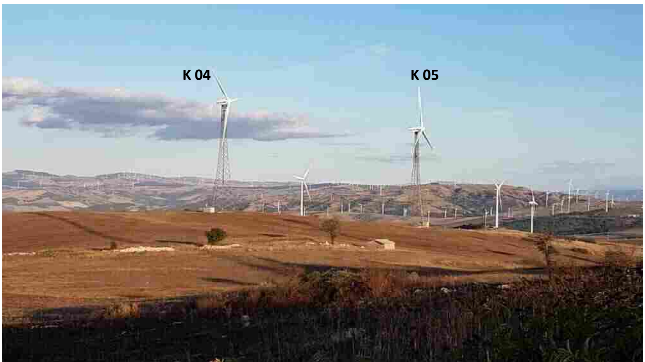
Foto 12 – Vista verso est, delle turbine K 04 , K 05 , da dismettere (Comune di Foiano di Val Fortore)
