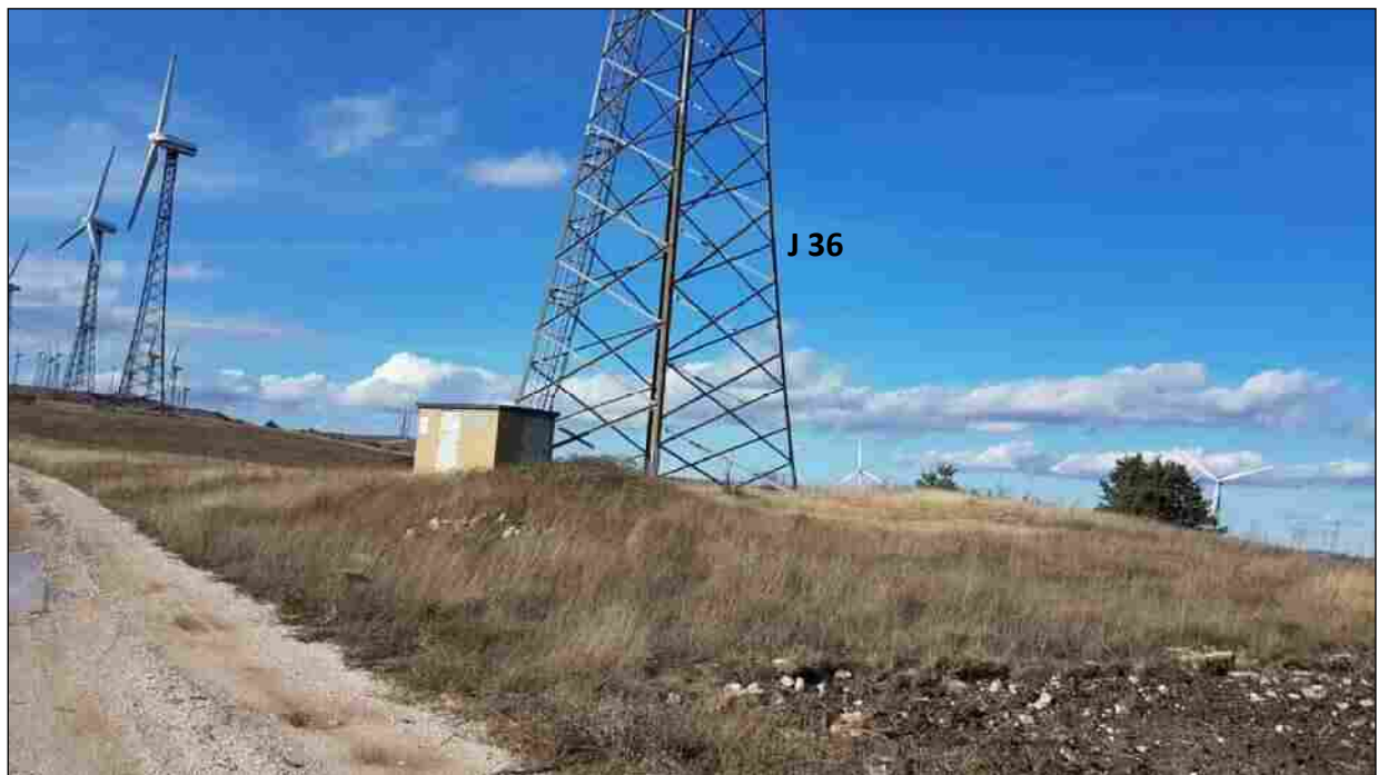
Foto 4 - Turbina J 36 da dismettere (Comune di Molinara)
