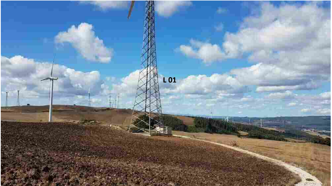
Foto 5 - Turbina L 01 da dismettere (Comune di Baselice)
