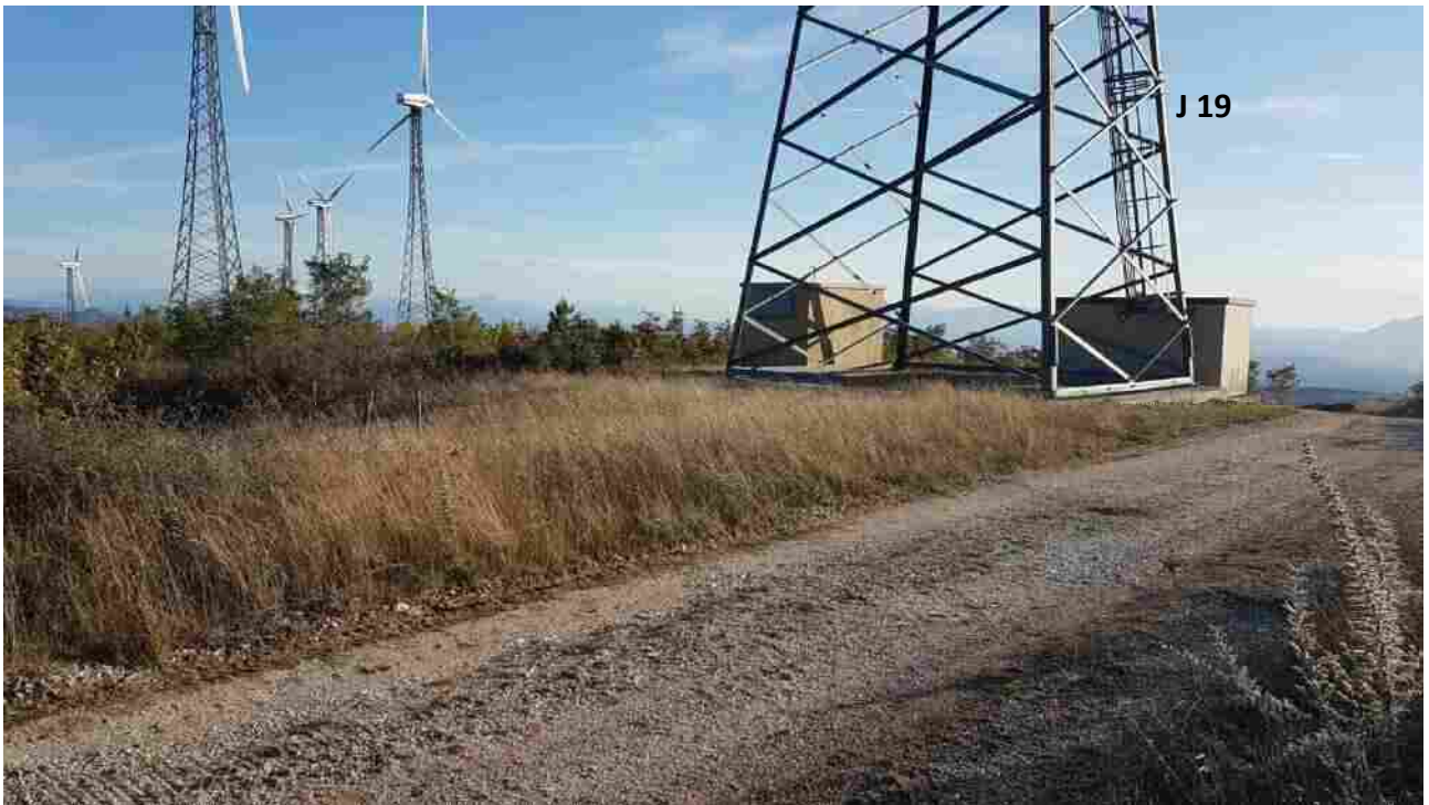
Foto 7 – Particolare settore basale della turbina J 19 da dismettere (Comune di San Marco dei Cavoti)
