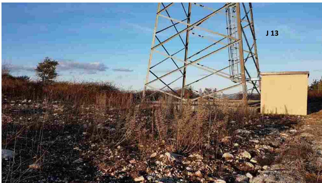
Foto 3 - Particolare parte basale turbina J 13 da dismettere (Comune di San Marco dei Cavoti)
