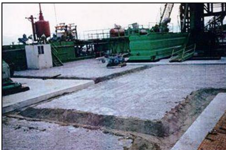
Figura 1.5: Predisposizione canalette grigliate perimetrali solette in cls.
