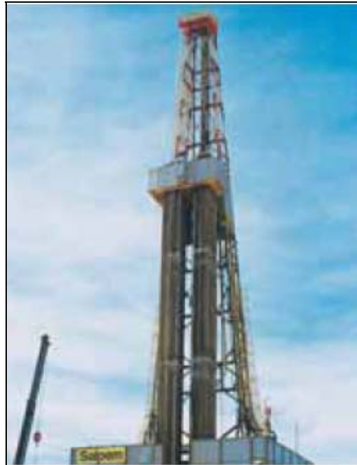
Figura 1.9: Impianto SAIPEM – EMSCO C2
