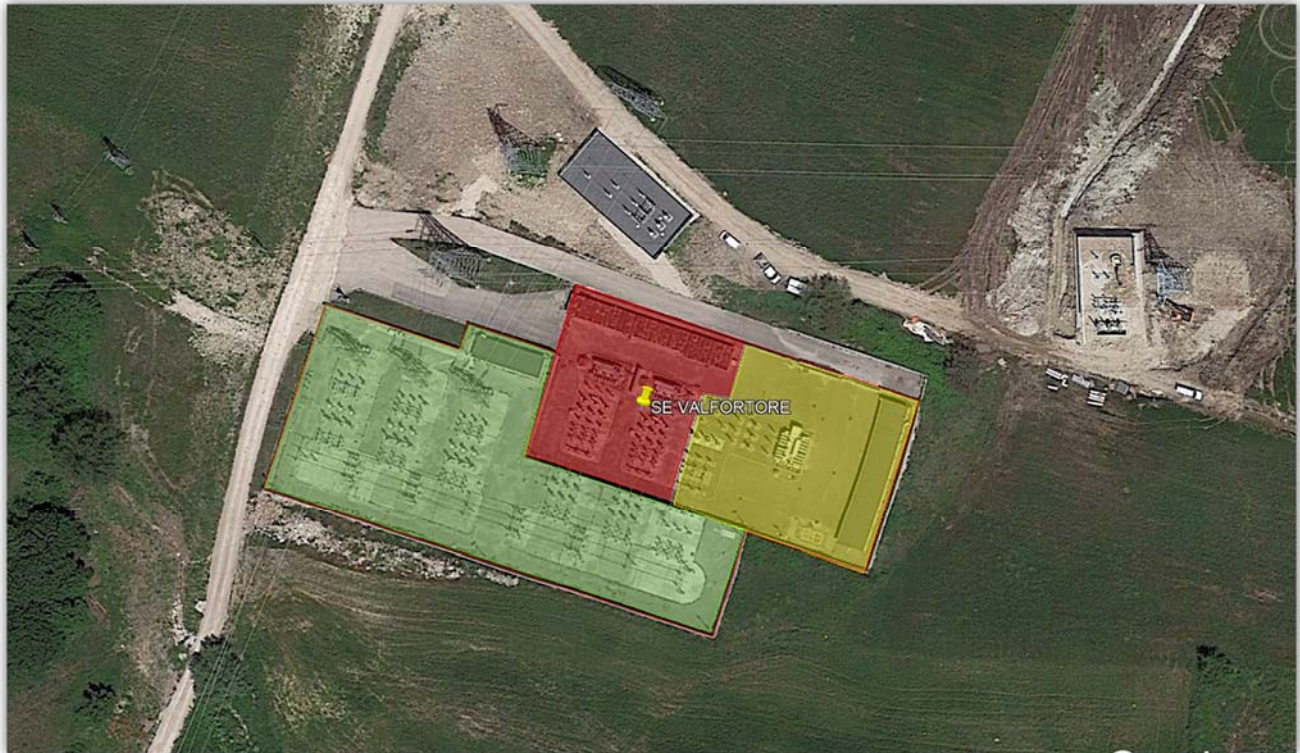
Fig. 3. Inquadramento su ortofoto del punto di connessione: in rosso la SSE esistente con i sue stalli AT oggetto di adeguamento di potenza e di tensione sul lato MT, che passa da 20 a 30kV. Anche i locali tecnici saranno rinnovati. In verde l'area TERNA; in giallo la SSE di altro produttore.
