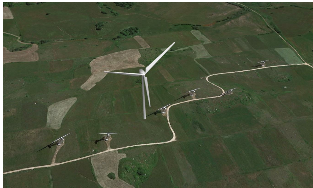
Sito di localizzazione dell'aerogeneratore di progetto SMC05
