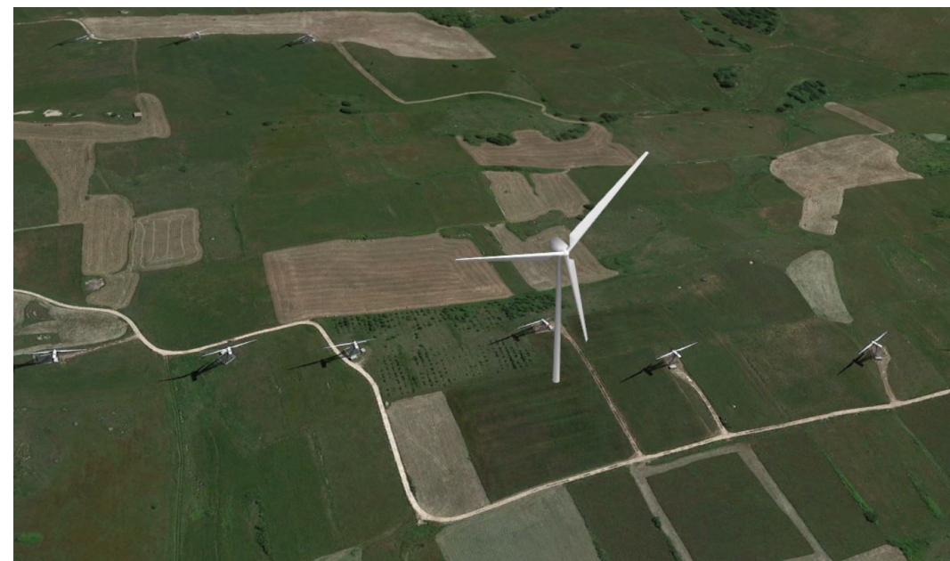
Sito di localizzazione dell'aerogeneratore di progetto SMC04
