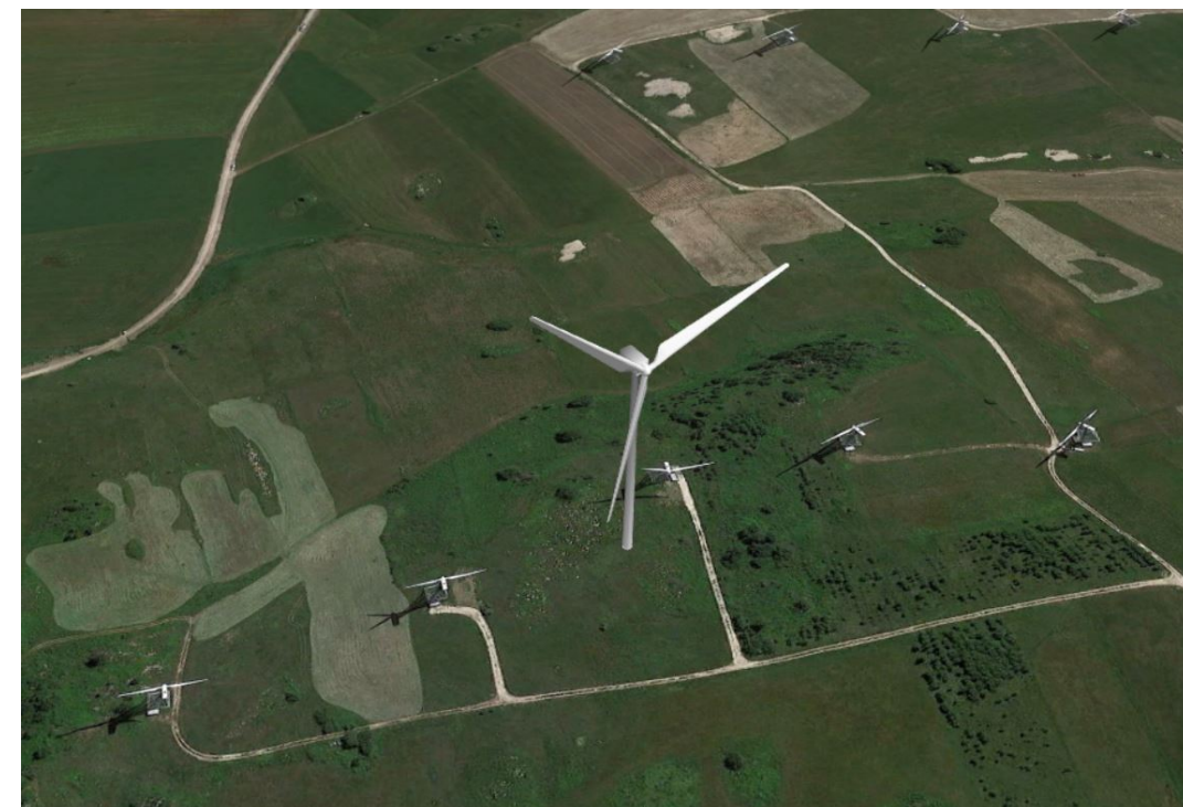
Sito di localizzazione dell'aerogeneratore di progetto SMC02 :
