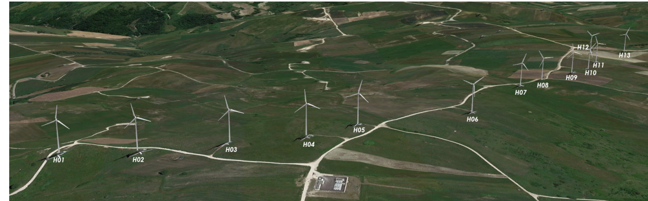
Layout impianto da dismettere -Aerogeneratori presenti nei territori comunali di Molinara e di San Giorgio La Molar
