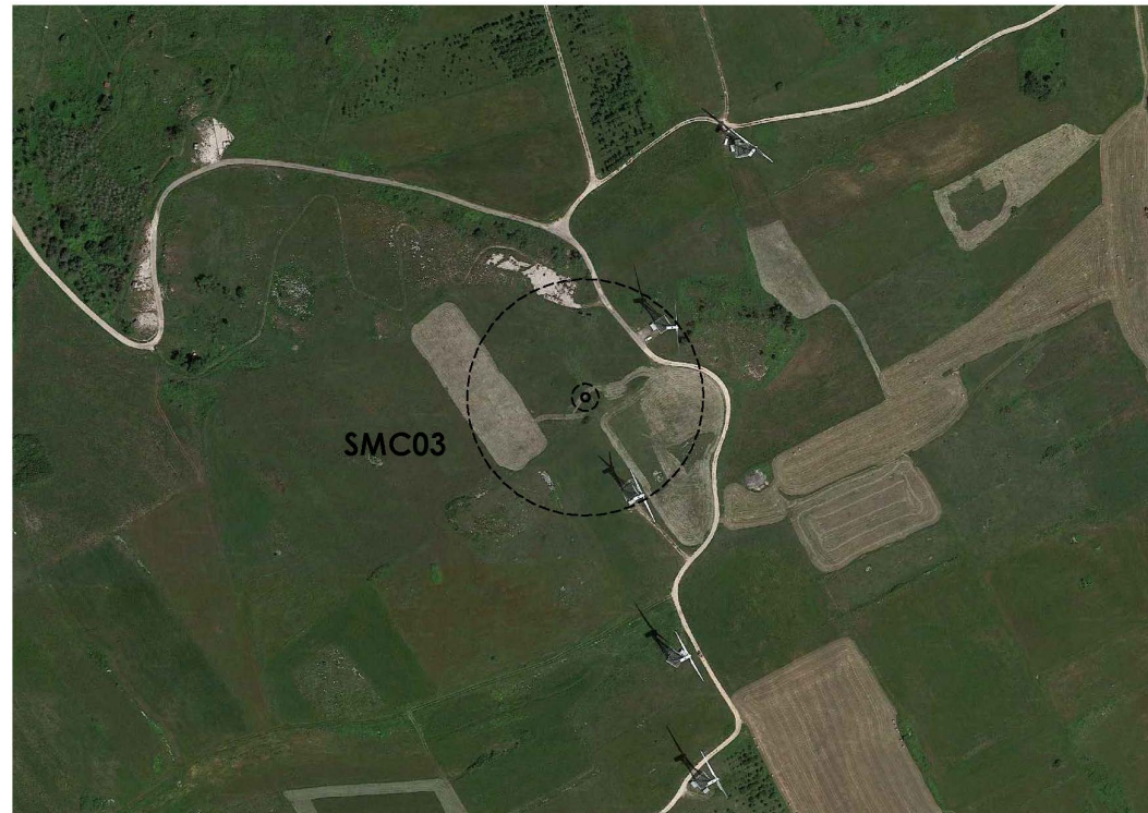
Sito di localizzazione dell'aerogeneratore di progetto SMC03 : foto aerea
