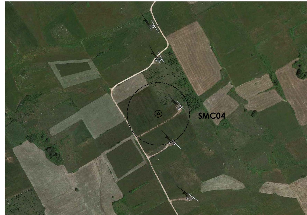
Sito di localizzazione dell'aerogeneratore di progetto SMC04 : foto aerea
