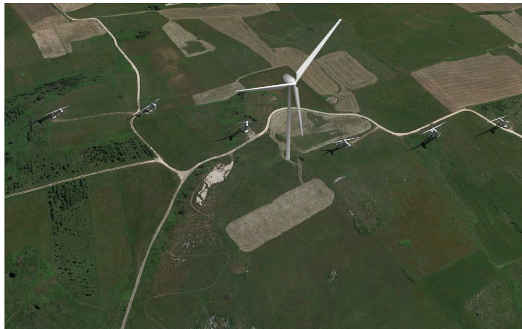
Sito di localizzazione dell'aerogeneratore di progetto SMC03
