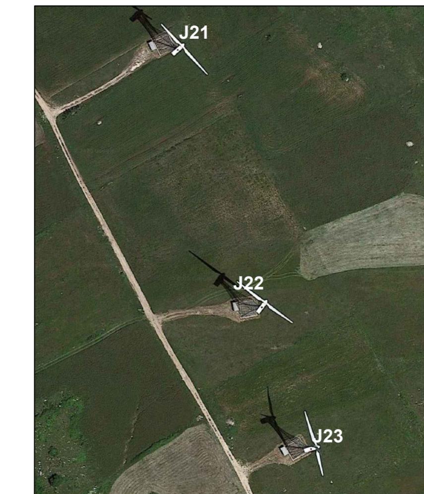
Ante Operam - Stato dei luoghi, aerogeneratori esistenti che saranno dismessi.
