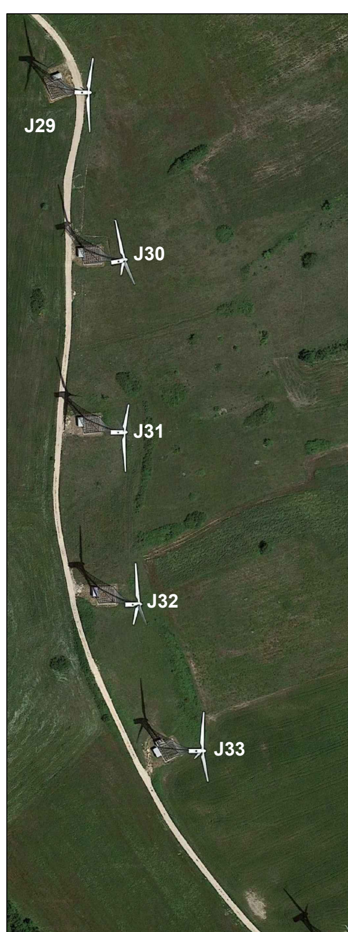
Ante Operam - Stato dei luoghi, aerogeneratori esistenti che saranno dismessi.
