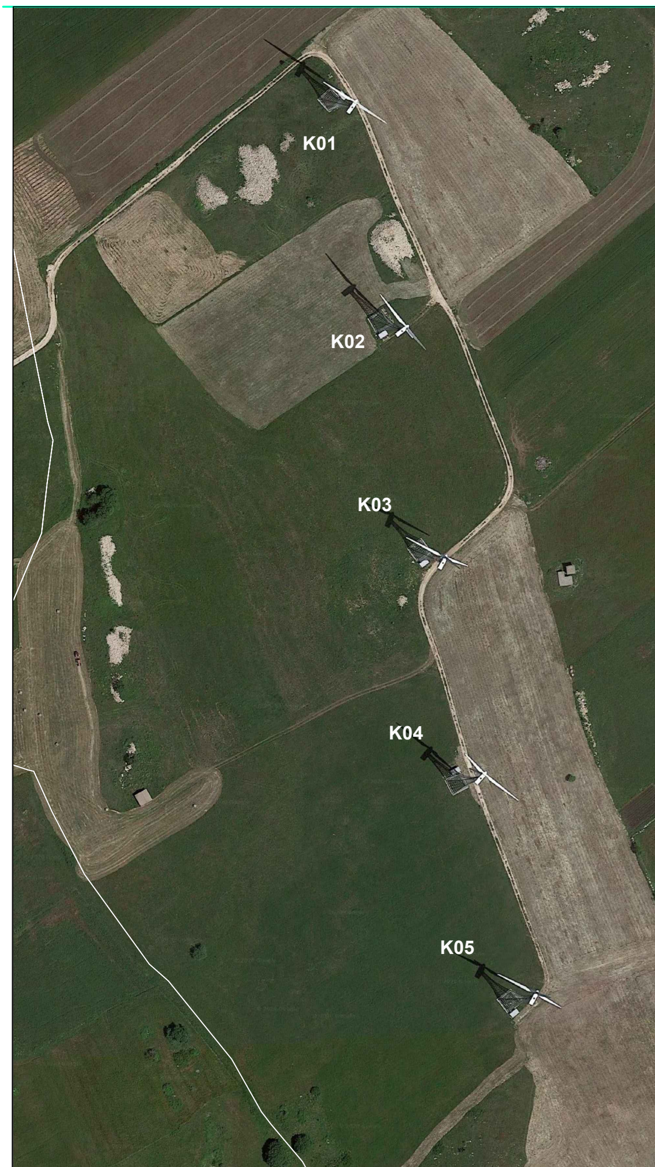
Ante Operam - Stato dei luoghi, aerogeneratori esistenti che saranno dismessi.
