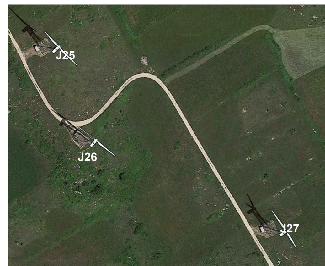
Ante Operam - Stato dei luoghi, aerogeneratori esistenti che saranno dismessi.
