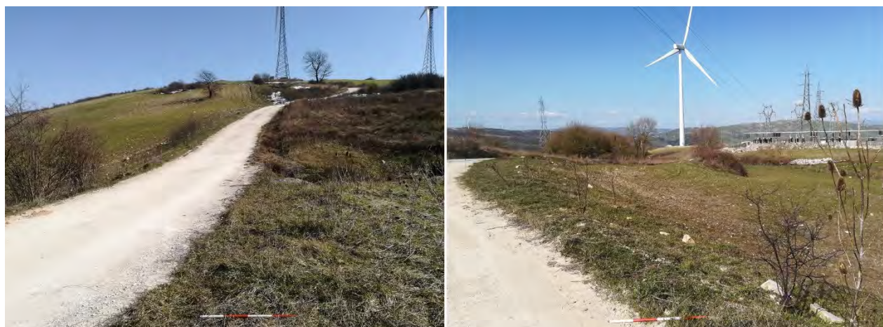
Foto 7-12 cavidotto lungo la strada sterrata verso la sottostazione
