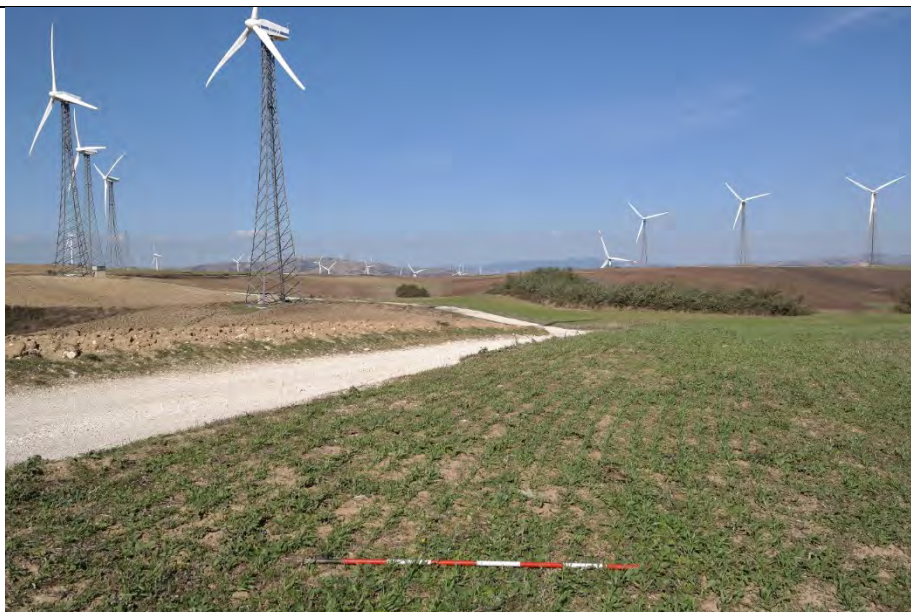
Foto 2: cavidotto in strada comunale Rossanello nei pressi di SGM02. Vista da sud
