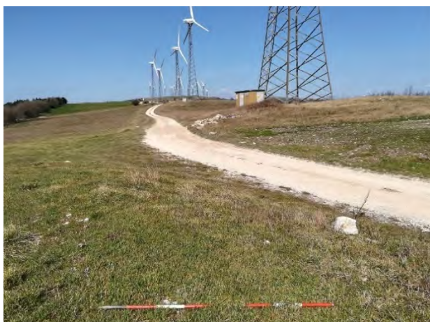
Foto 07-08 Cavidotto nei pressi di Mol02 lungo la via sterrata
