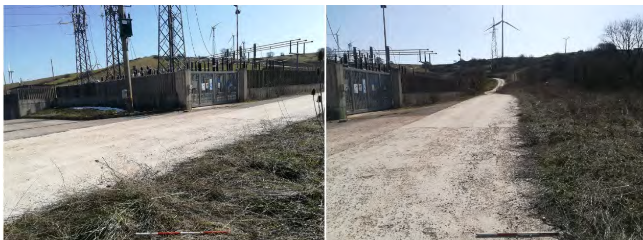
Foto 13-14 area di sottostazione esistente e cavidotto
