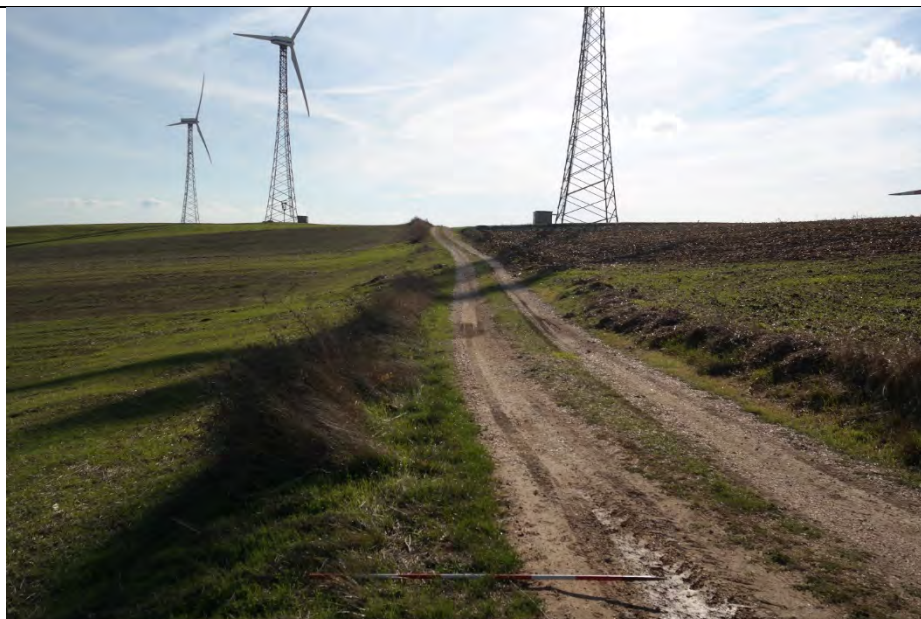
Foto 19: cavidotto in strada vicinale Crocelle nei pressi di SGM04. Vista da est
