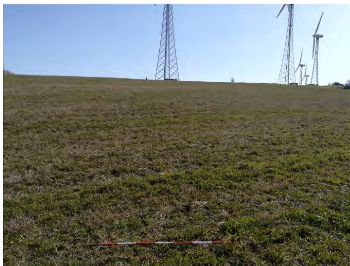
Foto 01-02-03 aerogeneratore MOL01 e cavidotto annesso
