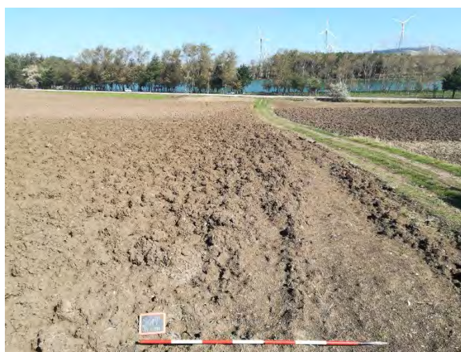
Foto 1: cavidotto da SP88 verso SGM06. Vista da sud ovest
