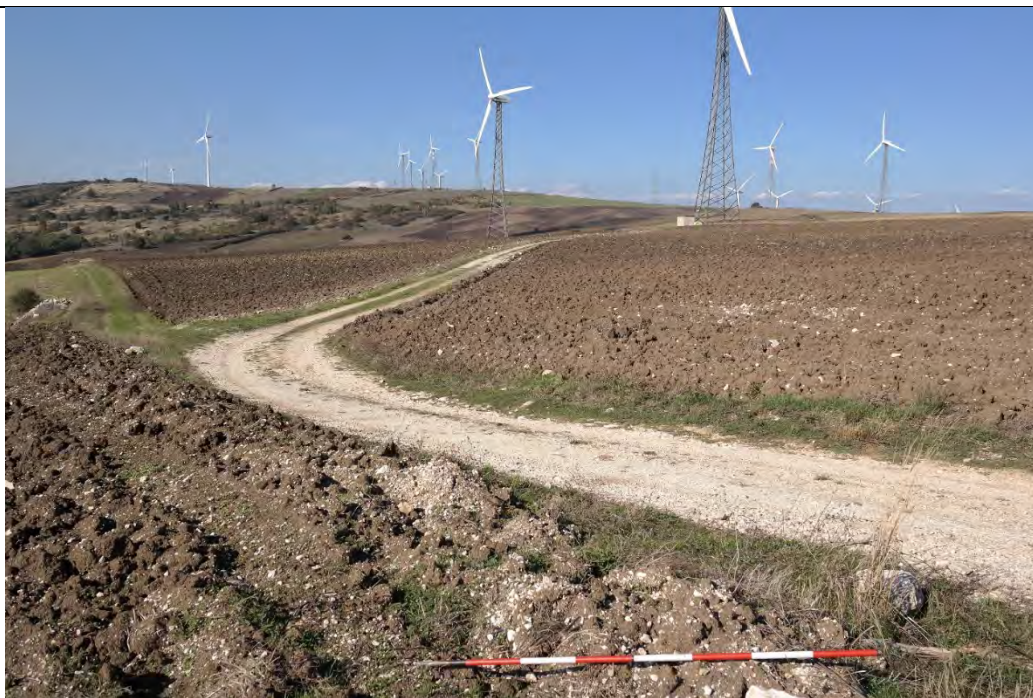
Foto 2: cavidotto in strada vicinale Crocelle nei pressi di SGM03. Vista da sud
