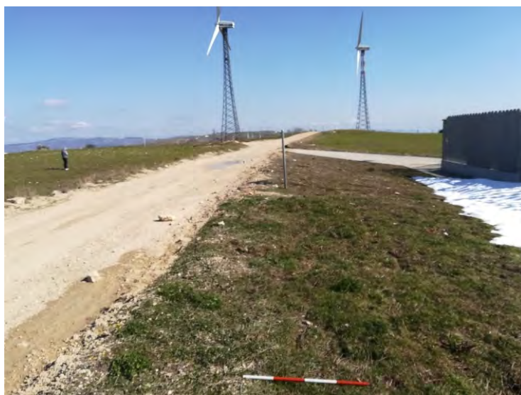
Foto 19-22 cavidotto lungo il declivio del colle, nelle vicinanze di MOL06 e all'incrocio con il tratto che porta alla sottostazione
