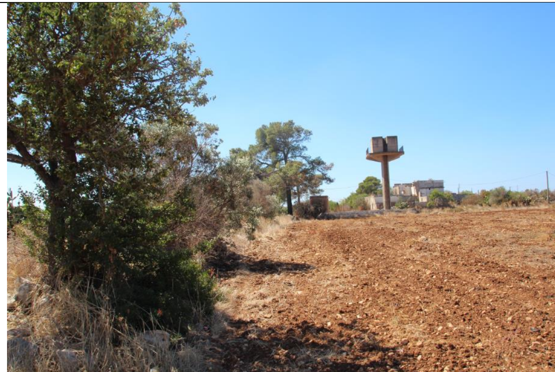
Punto scatto n.34: Serbatoio pensile a scopo irriguo
