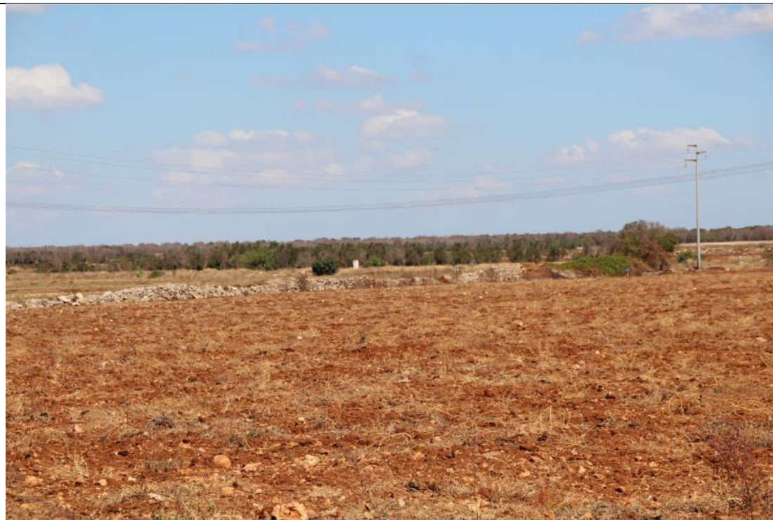
Punto scatto n.37: Linee elettriche aeree MT
