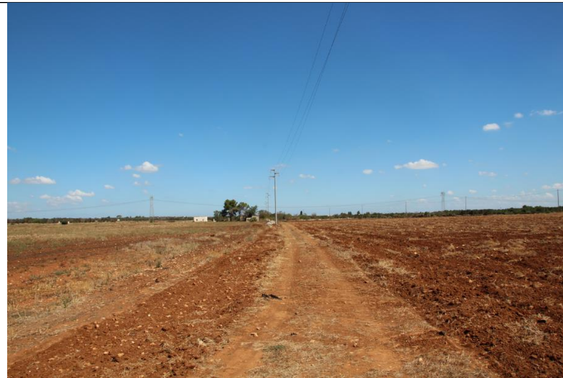
Punto scatto n.38: Linee elettriche aeree MT
