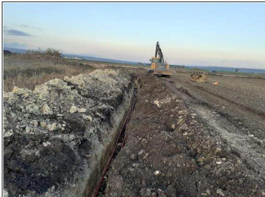
*Esempio di stoccaggio temporaneo a bordo scavo del materiale di risulta dallo scavo di un cavidotto*
