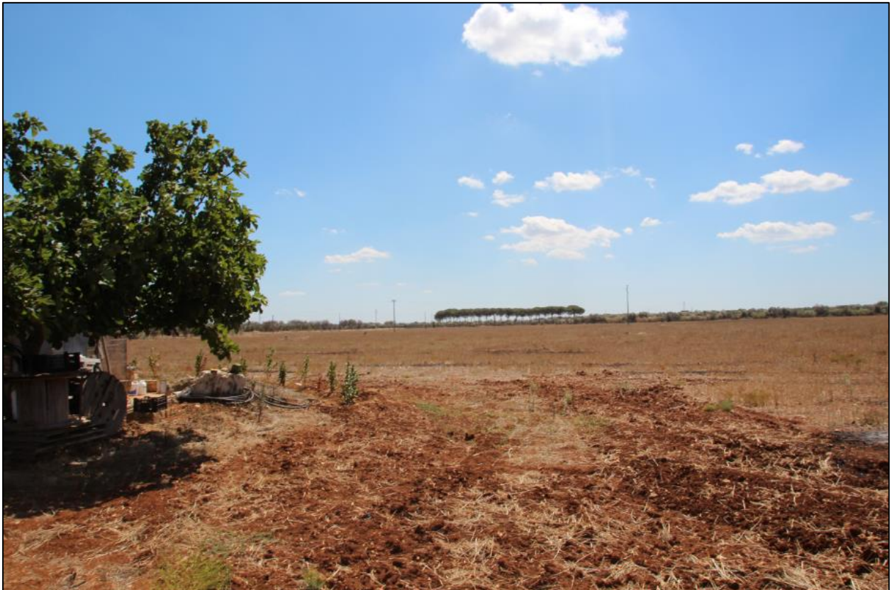
Foto demolizione n. 4 – Rudere
