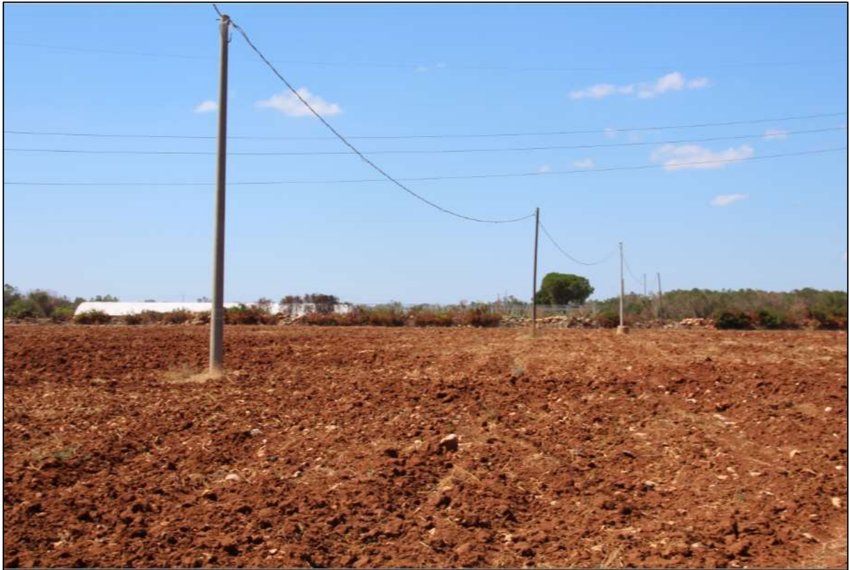
Foto demolizione n. 6 – Linee elettriche aeree da interrare
