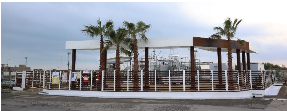
Figura 2-4: Vista recinzione in acciaio Cor-Ten attualmente installata presso l'impianto FORSU all'interno della Raffineria di Gela
