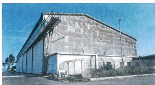
Hangar 100 – prospetto sud
