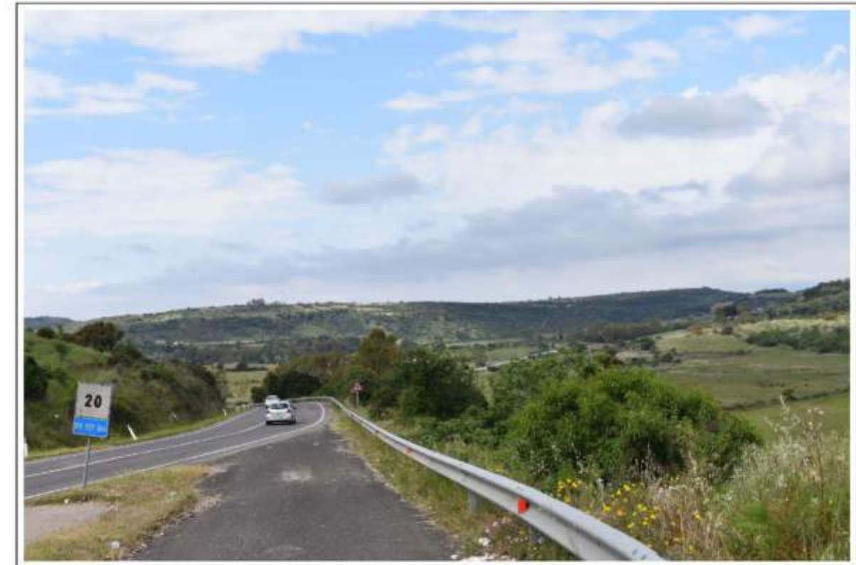
Vista dal km 20 della S.S. 127 bis - Stato di fatto
