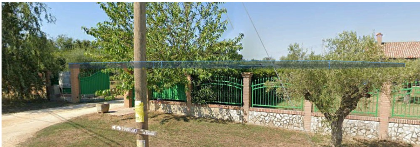
Fig 29 posizione punto di ripresa presso il PSO B verso l'impianto (aree azzurra)
