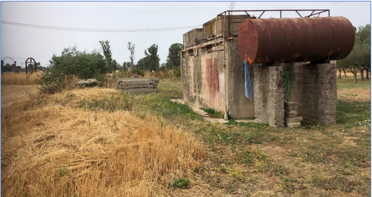
Il settore nord del sito
