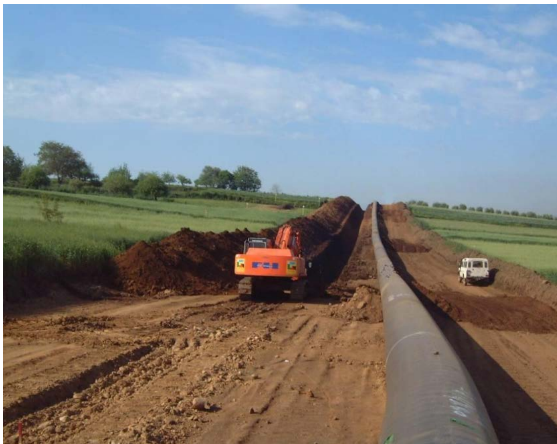
Foto 7.1.6/A - Scavo della trincea
