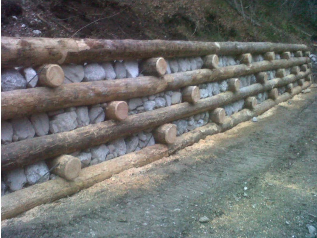
Foto 8.1.1/G - Ricostituzione spondale con muro cellulare in legname e pietrame
