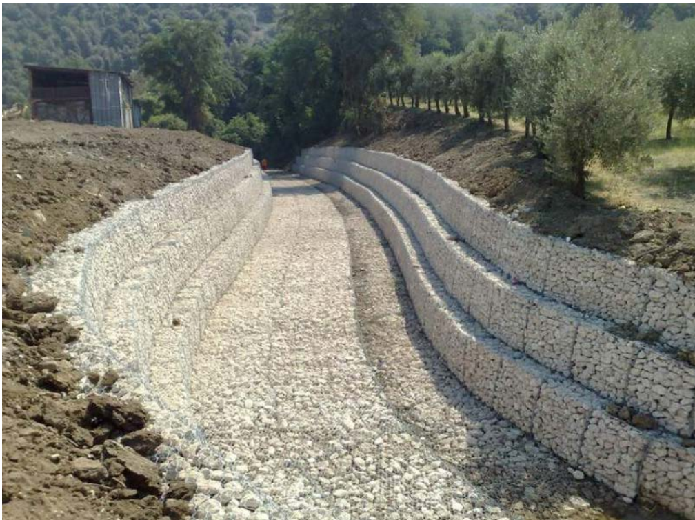
Foto 8.1.1/L – Ricostruzione dell'alveo con gabbioni e materassi metallici
