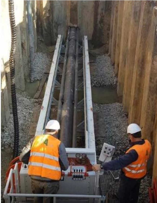
Foto 7.1.10/A - Trivellazione con spingitubo
