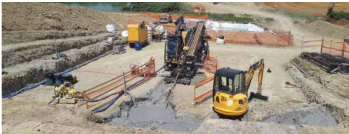
Foto 7.1.11/A – Rig e area di cantiere
