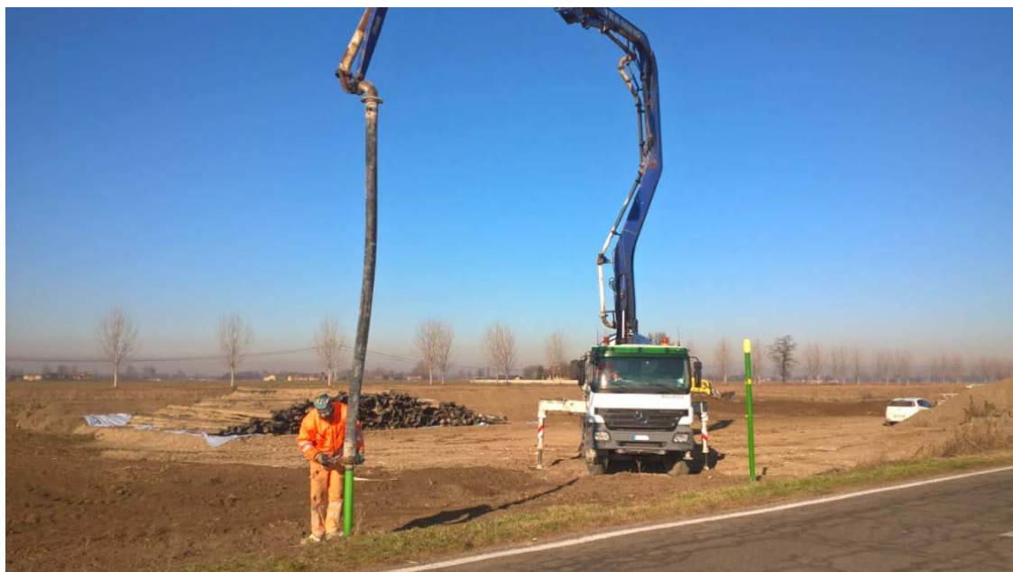
Foto 7.2.7/A – Inertizzazione del tubo di protezione
