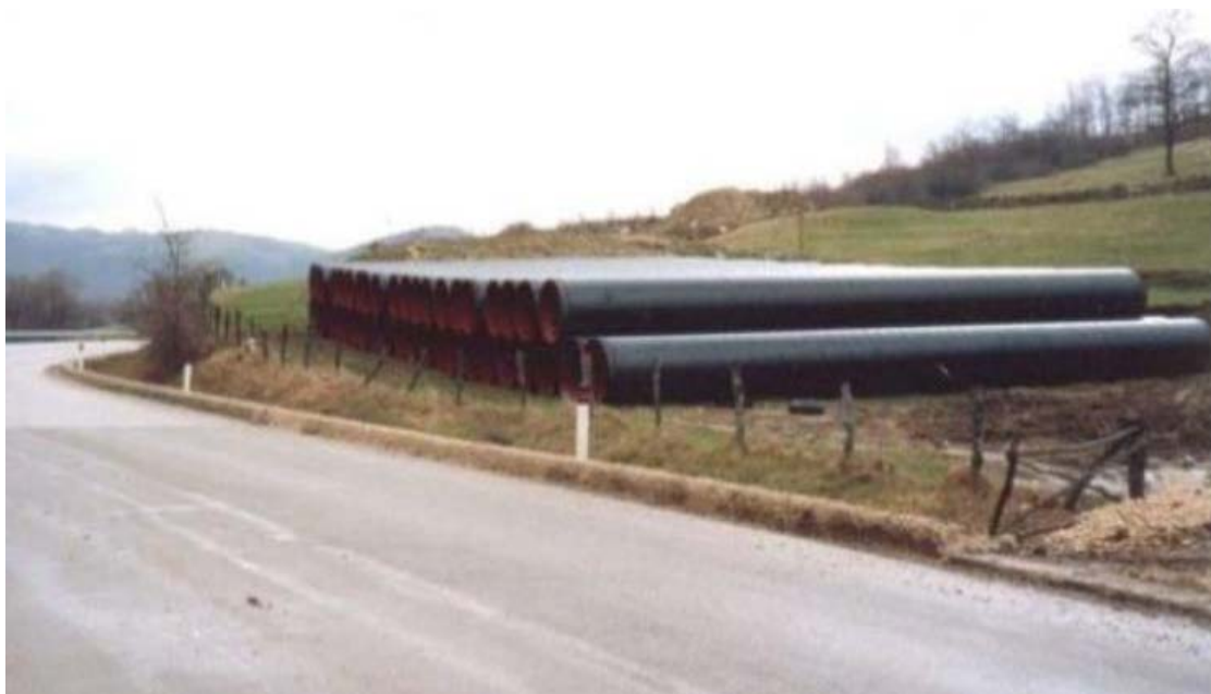
Foto 7.1.1/A - Piazzola di accatastamento tubazioni
