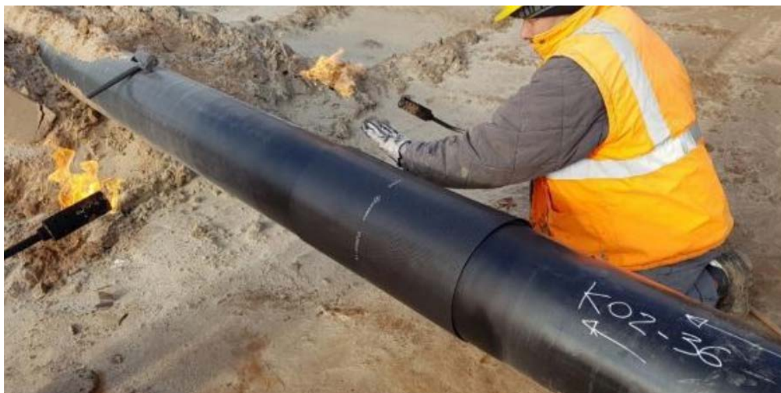
Foto 7.1.7/A - Applicazione manuale di una fascia termo-restringente su giunto di saldatura
