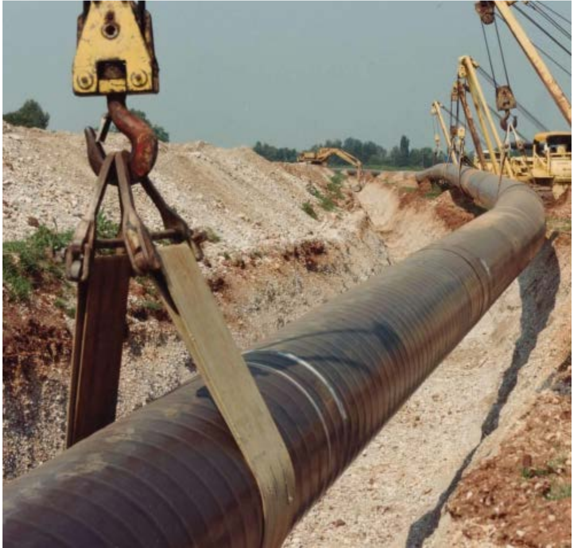
Foto 7.1.8/A – Posa della condotta
