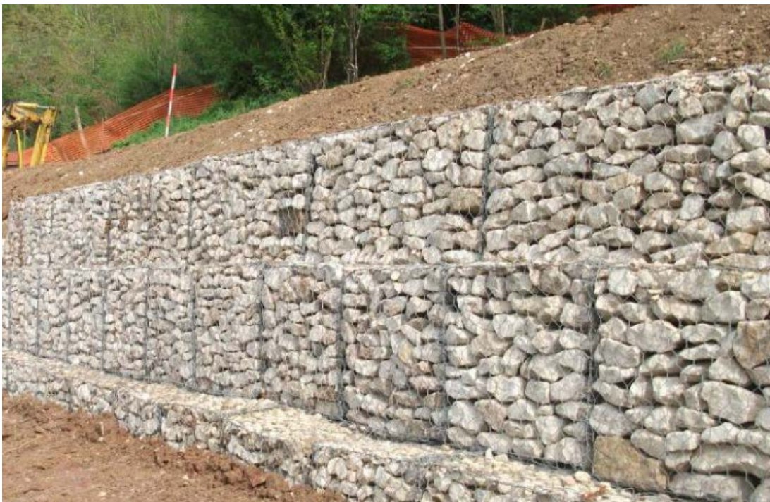
Foto 8.1.1/C – Muro gradonato in gabbioni
