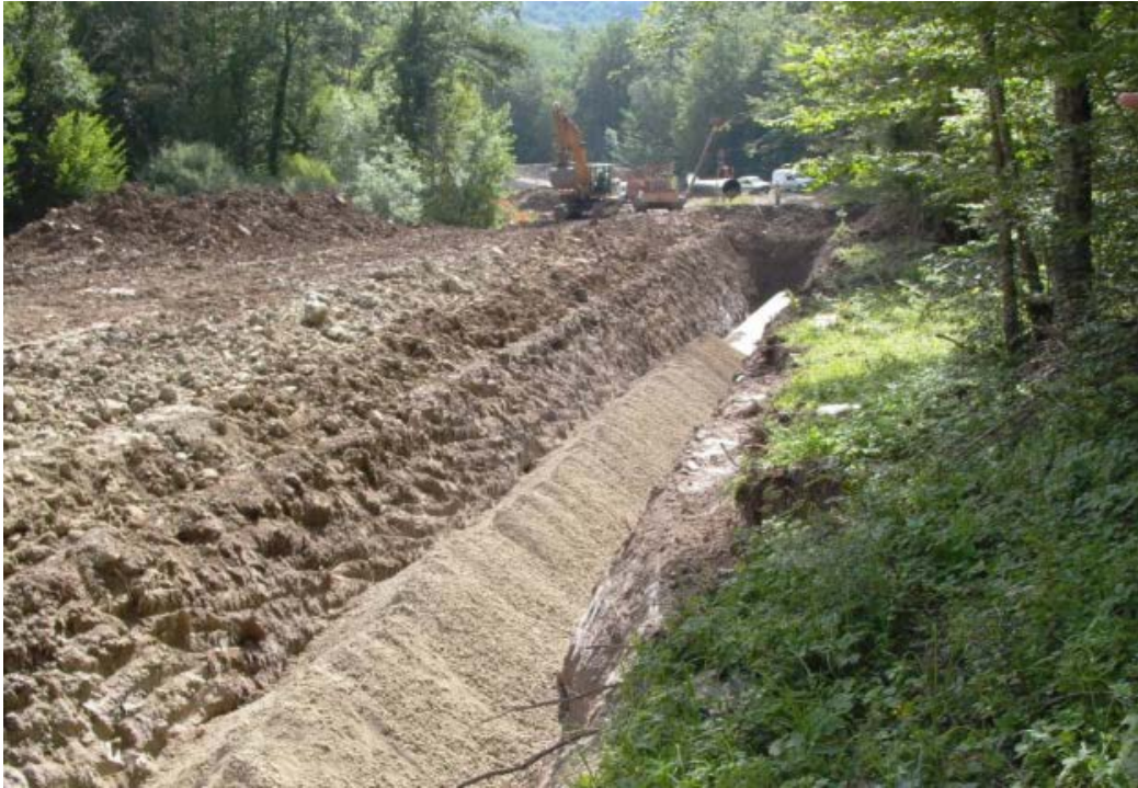
Foto 7.1.9/A – Pre-rinterro della condotta
