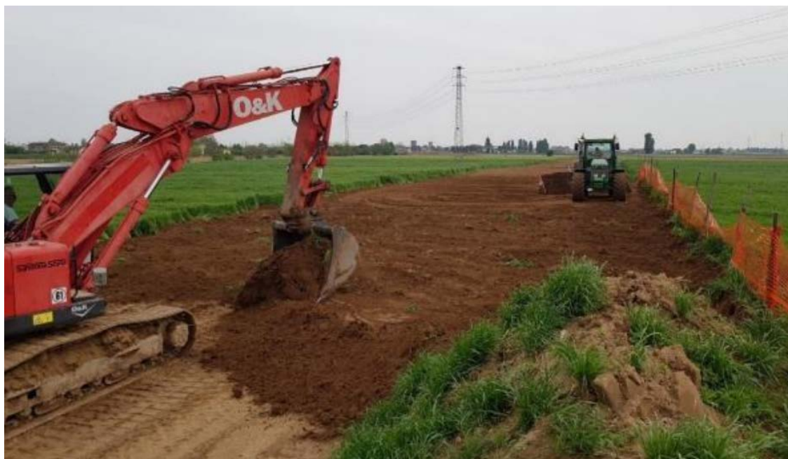
Foto 7.1.9/C - Distribuzione dello strato humico superficiale
