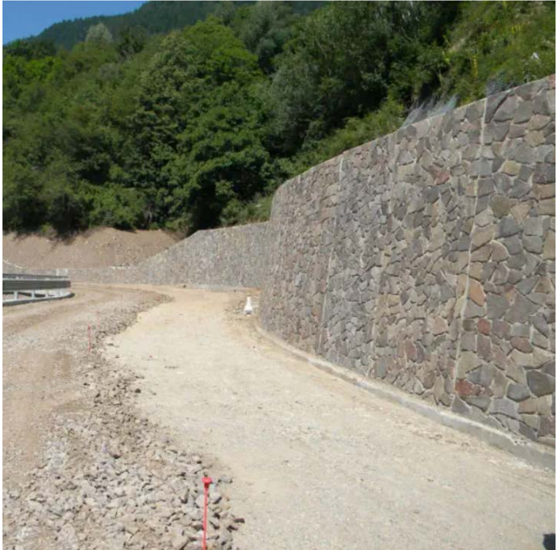
Foto 8.1.1/D – Muro di contenimento in c.a.
