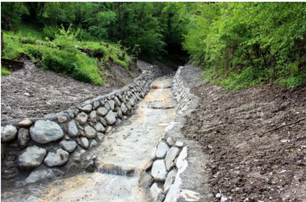
Foto 8.1.1/H – Regimazione di piccoli corsi d'acqua con cunetta in massi
