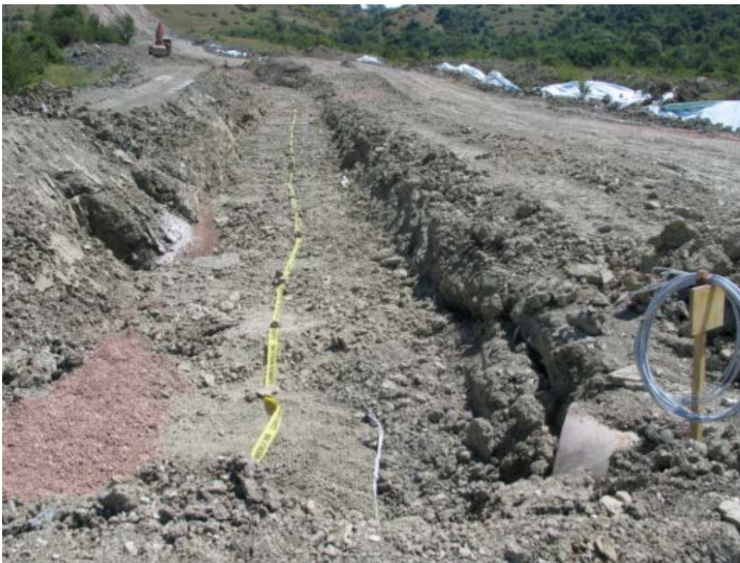
Foto 7.1.9/B - Rinterro della condotta e posa nastro di avvertimento
