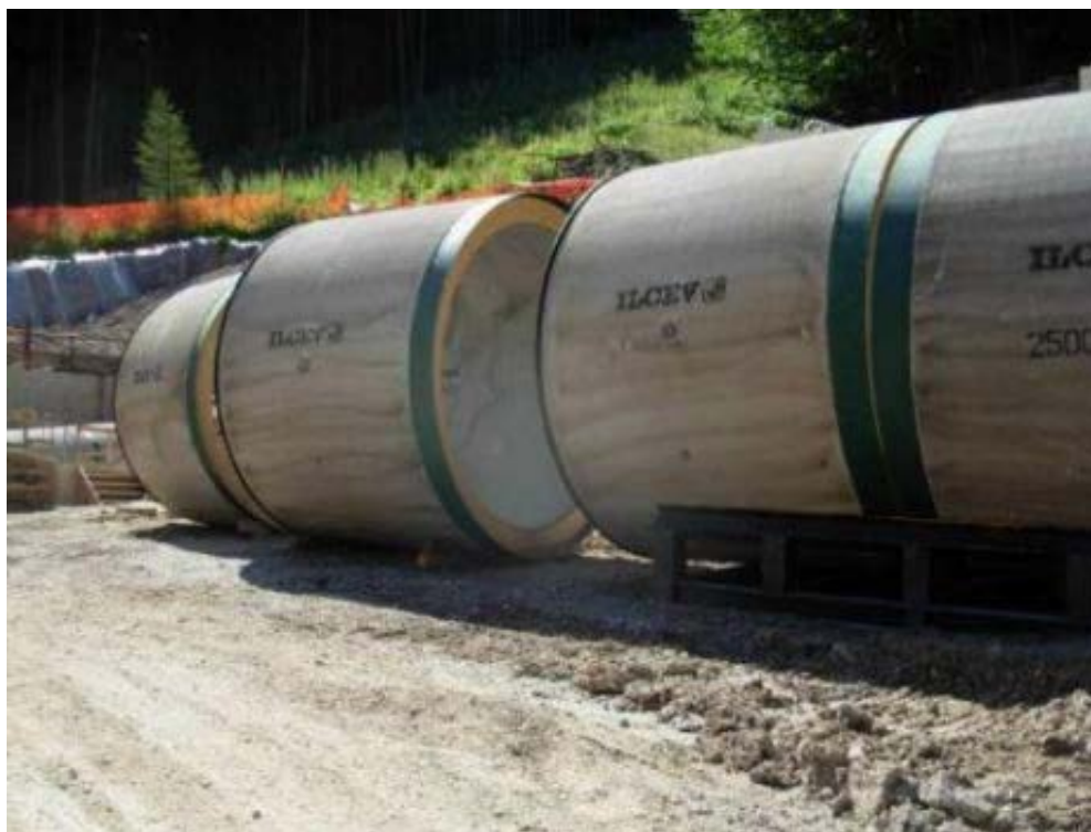
Foto 7.1.11/D - Stoccaggio tubi in c.a
