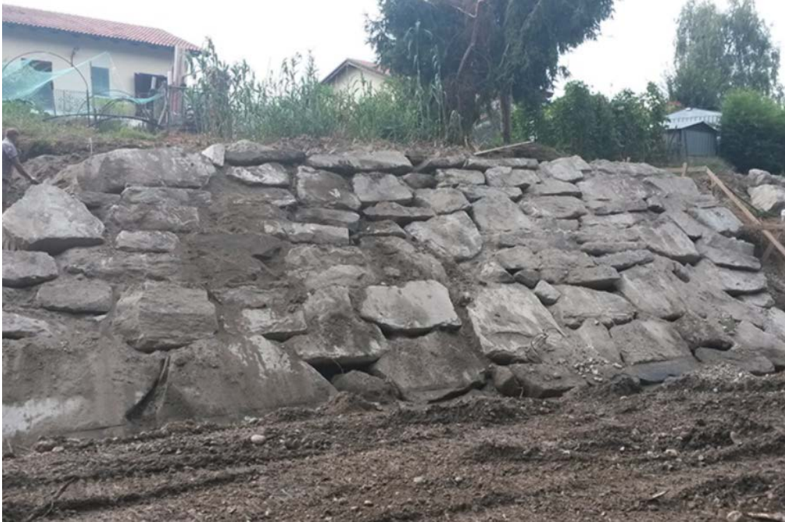
Foto 8.1.1/I – Rivestimento spondale in massi
