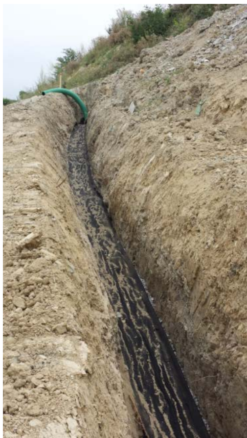
Foto 8.1.1/N – Trincea drenante sotto condotta
