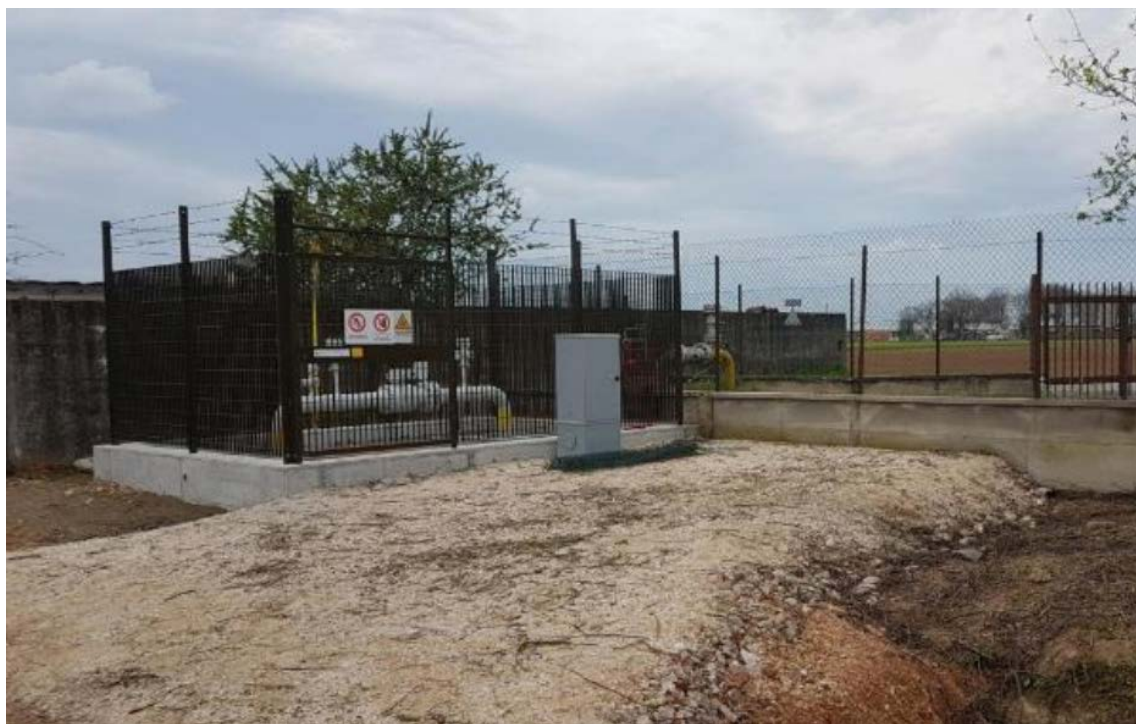
Foto 7.1.12/A - Esempio di impianto al termine dei lavori
