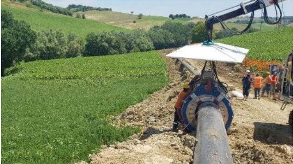
Foto 7.1.4/B - Saldatura automatica
