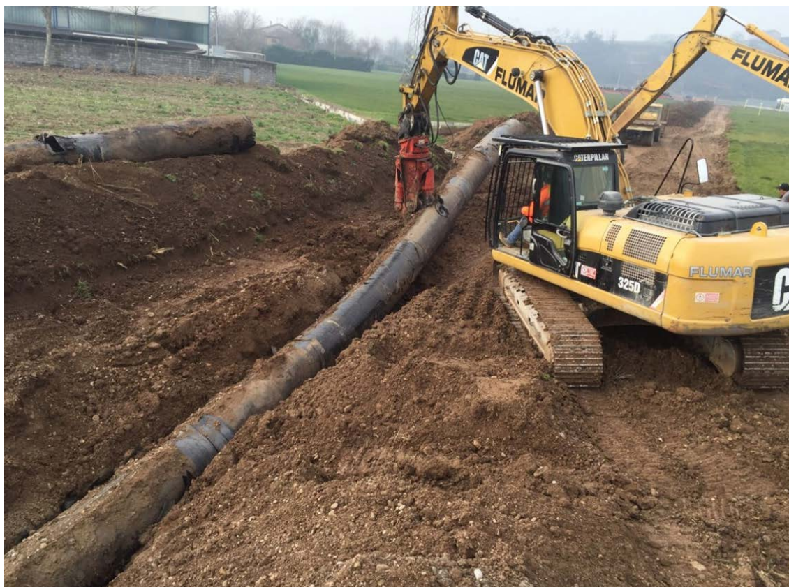
Foto 7.2.5/A - Sollevamento tubazione sezionata da rimuovere
