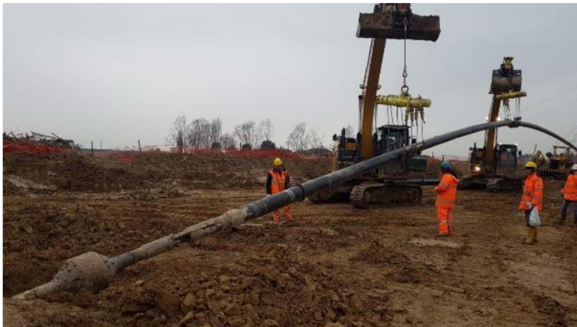
Foto 7.1.11/B - Operazione di varo della TOC
