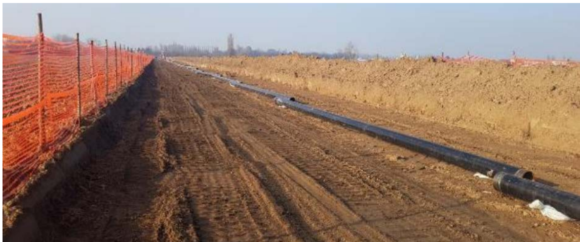
Foto 7.1.3/A – Sfilamento delle tubazioni di linea
