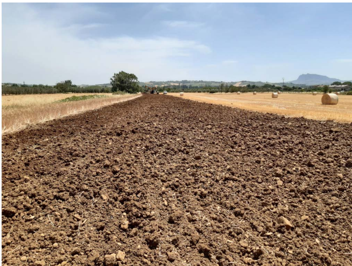
Foto 7.1.2/B - Apertura dell'area di passaggio (fase 2)
