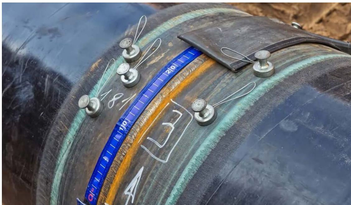
Foto 7.1.5/A - Controlli non distruttivi sulle saldature
