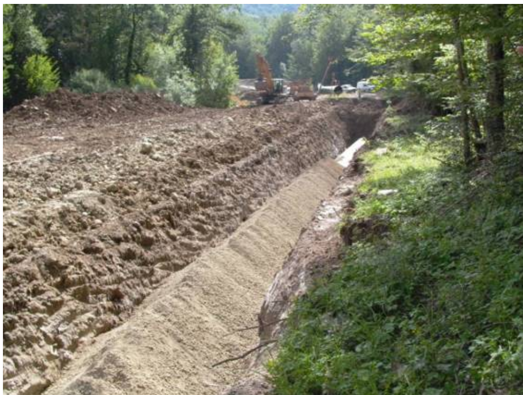
Foto 2.2-5: Rinterro della condotta
