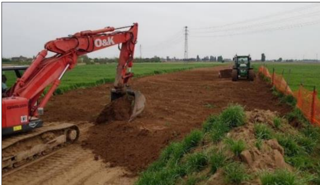
Foto 2.2-6: Ridistribuzione dello strato humico superficiale
