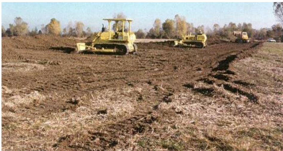
Foto 2.2-2 - Apertura dell'area di passaggio
