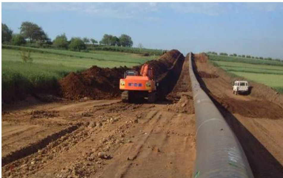
Foto 2.2-3: Scavo della trincea
