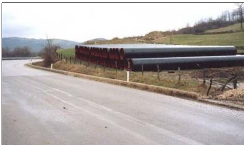
Foto 2.2-1: Piazzola di accatastamento tubazioni
