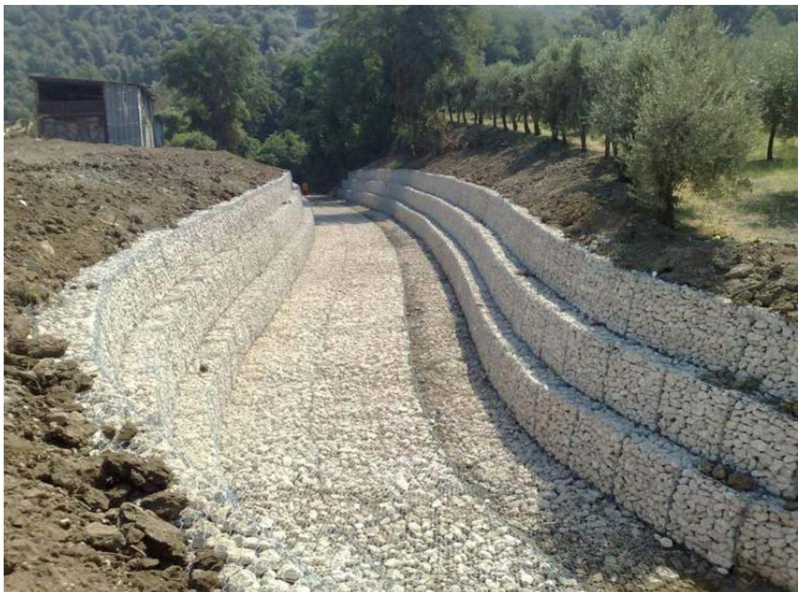
*Foto 2.3.5/L – Ricostruzione dell'alveo con gabbioni e materassi metallici*
