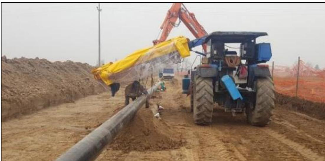
**Foto 2.3.1/D** - Esempio di saldatura manuale
