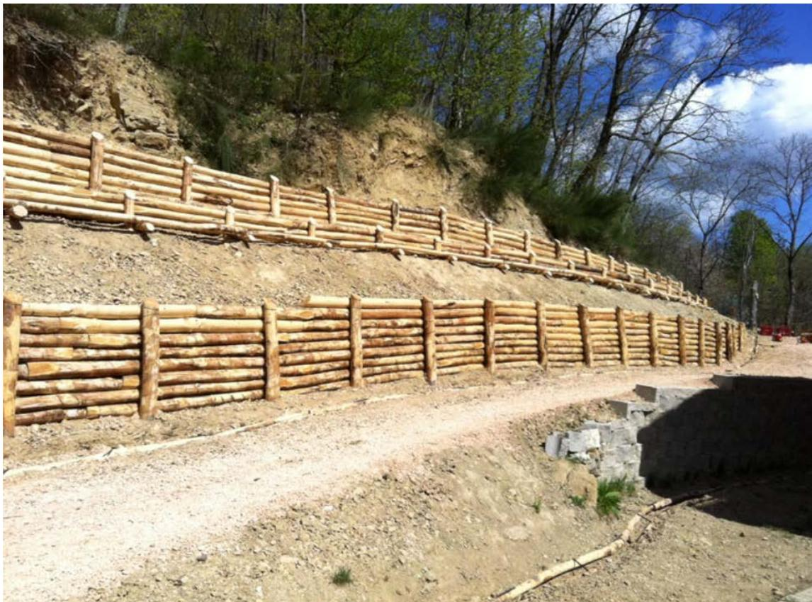
**Foto 2.3.5/A** – Palizzate di contenimento in legname
