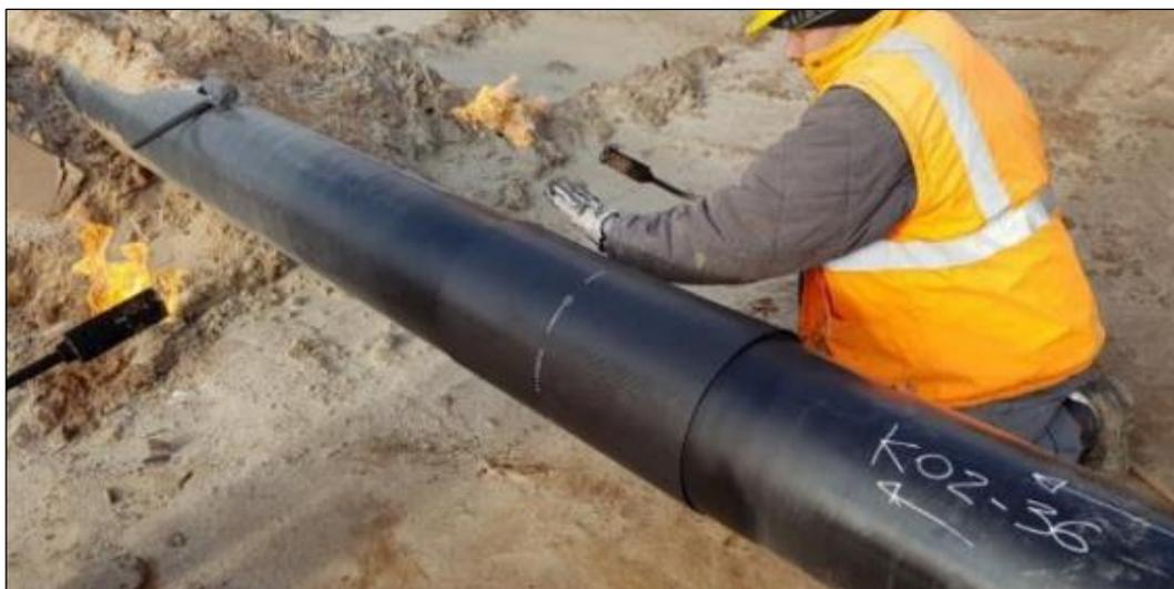
*Foto 2.3.1/G - Applicazione manuale di una fascia termorestringente su giunto di saldatura*
