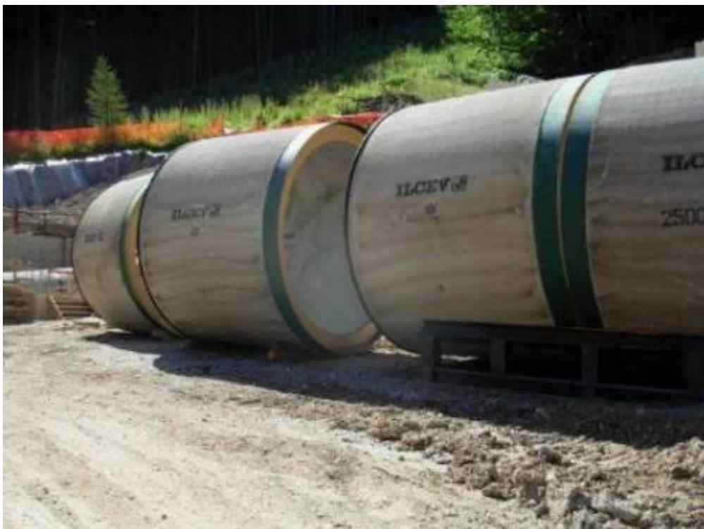
**Foto 2.3.2/E** - Stoccaggio tubi in c.a
