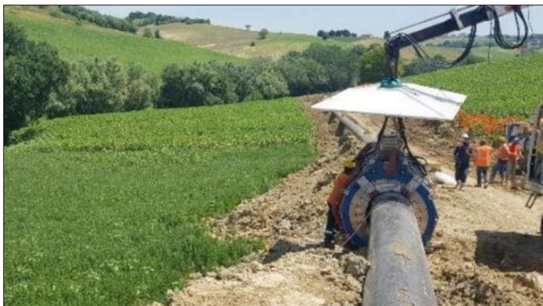
**Foto 2.3.1/E** - Esempio di saldatura automatica
