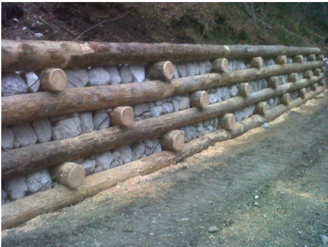
**Foto 2.3.5/G** - Ricostituzione spondale con muro cellulare in legname e pietrame
