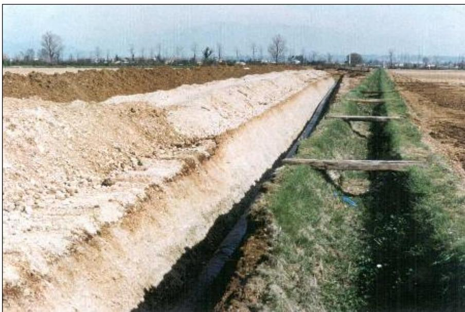
**Foto 2.2.1/I** - Tratto di condotta posata, si nota l'accantonamento dello strato humico separato dal materiale di scavo della trincea
