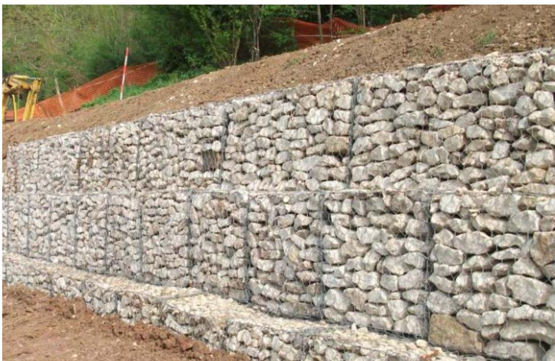
**Foto 2.3.5/C** – Muro gradonato in gabbioni
