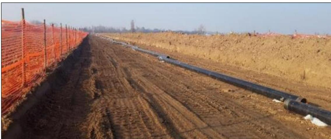
**Foto 2.3.1/C** Sfilamento delle tubazioni di linea
