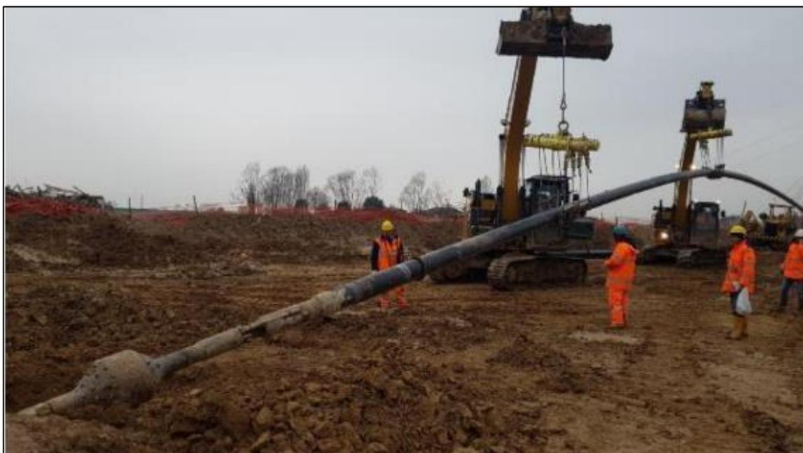
**Foto 2.3.2/B** - Esempio di operazione di varo della TOC
