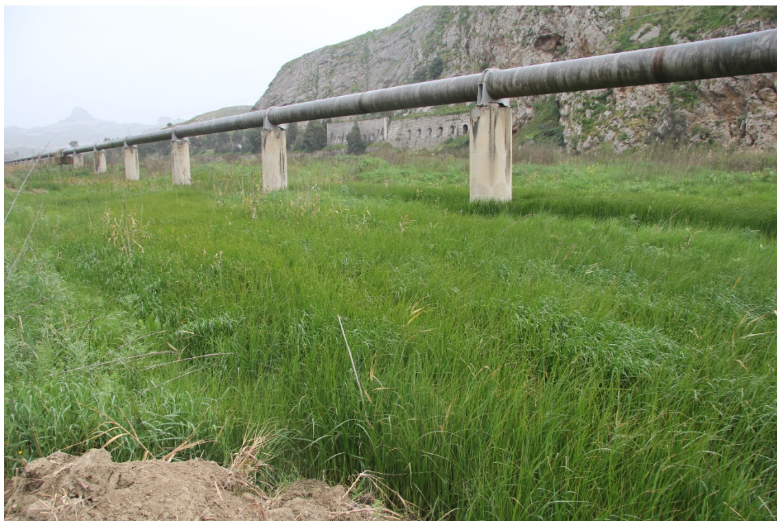
Foto 5.11 - Prateria igrofila a Bolboschoenus maritimus in corrispondenza del km 6,00 della condotta in progetto.
