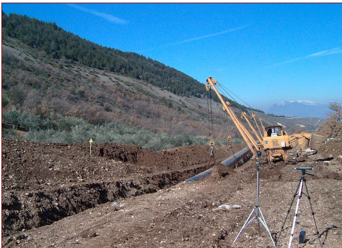
Figura 4/A – Rilievi fonometrici durante la posa della condotta in un cantiere equivalente
