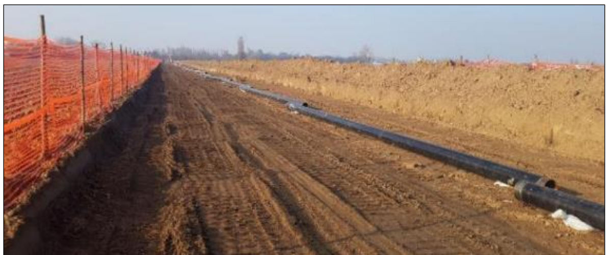
Foto 3.2.1/C Sfilamento delle tubazioni di linea
