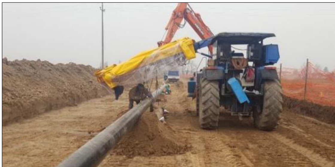
Foto 3.2.1/D Esempio di saldatura manuale
