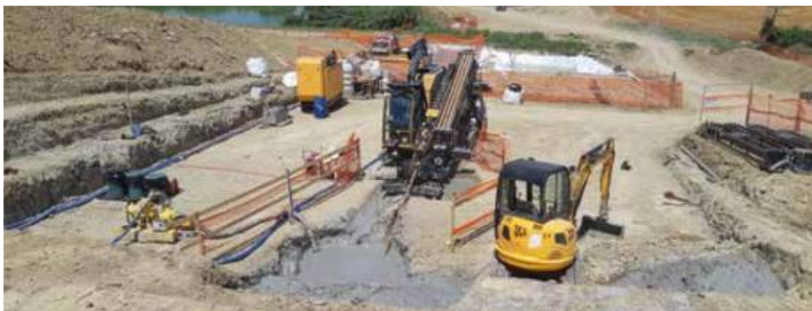
Foto 3.2.2/A Rig e area di cantiere
