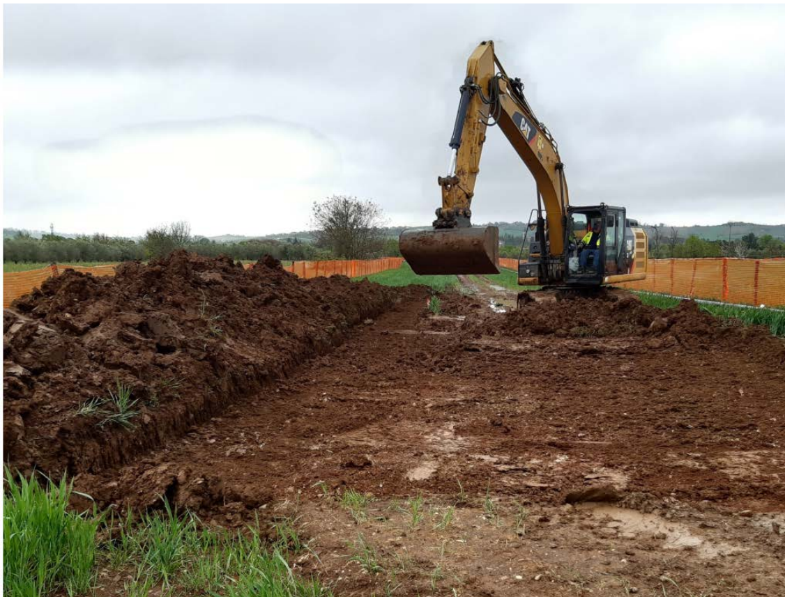
Foto 3.2.1/B Apertura dell'area di passaggio
