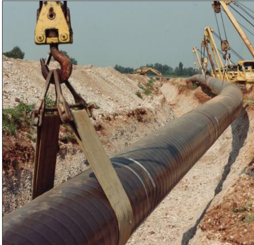
Foto 3.2.1/H Posa della condotta (esempio di condotta con diametro superiore alla linea in progetto)
