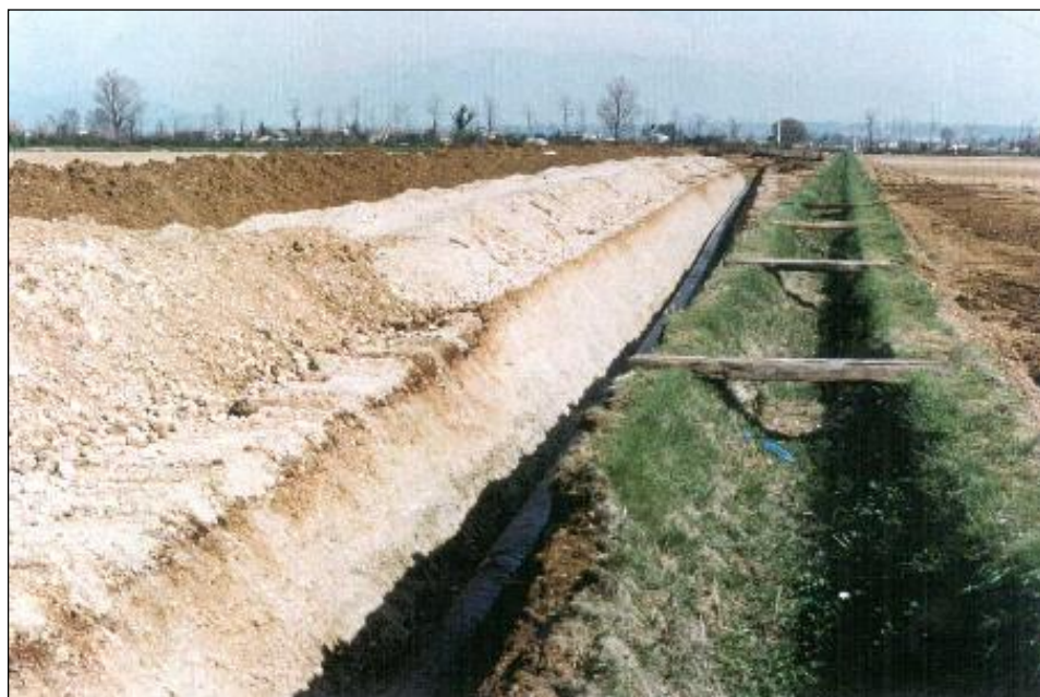
Foto 3.2.1/I Tratto di condotta posata, si nota l'accantonamento dello strato humico separato dal materiale di scavo della trincea
