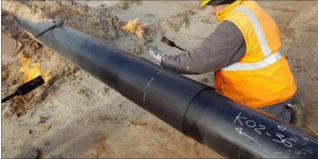
Foto 3.2.1/G Applicazione manuale di una fascia termorestringente su giunto di saldatura
