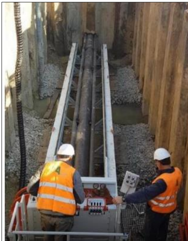
Foto 3.2.1/L Trivellazione con spingitubo
