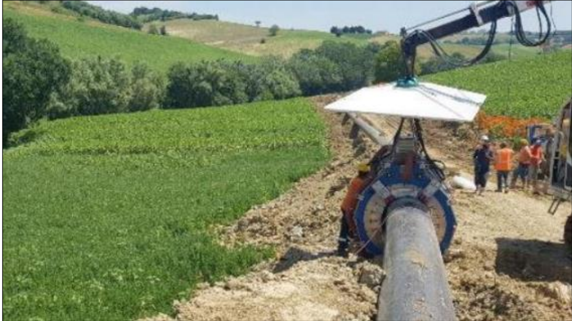
Foto 3.2.1/E Esempio di saldatura automatica
