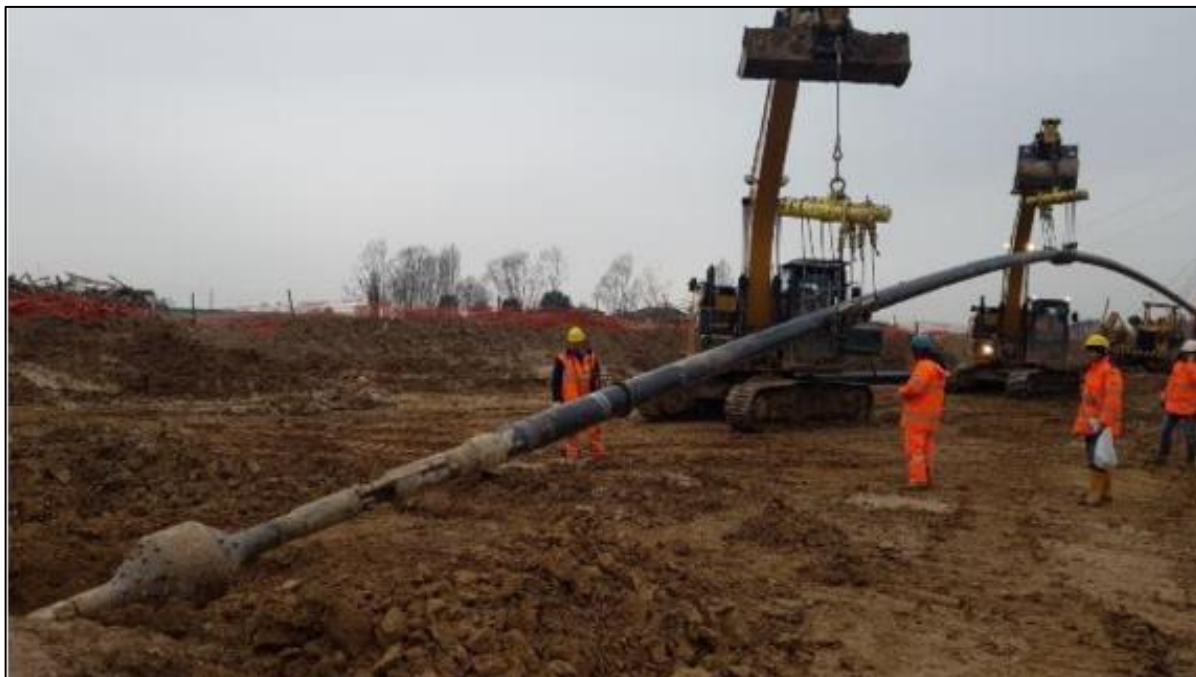
Foto 3.2.2/B Esempio di operazione di varo della TOC
