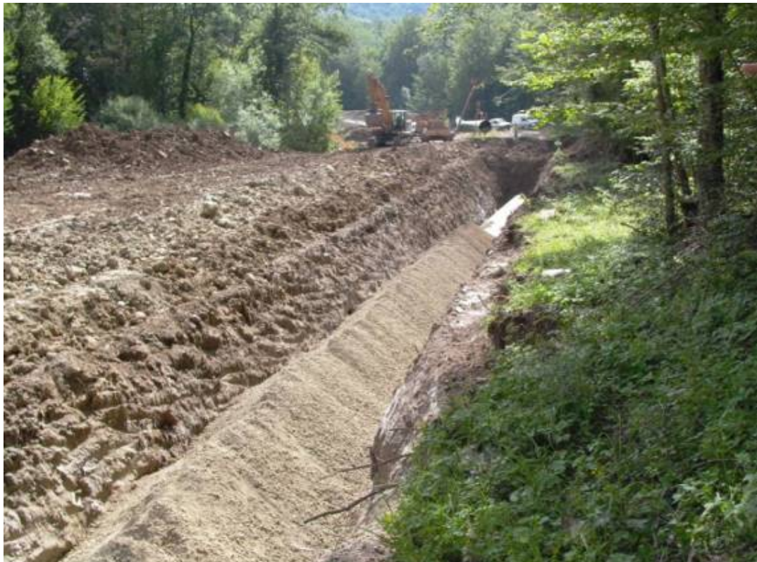
Foto 3.2.1/J Rinterro della condotta
