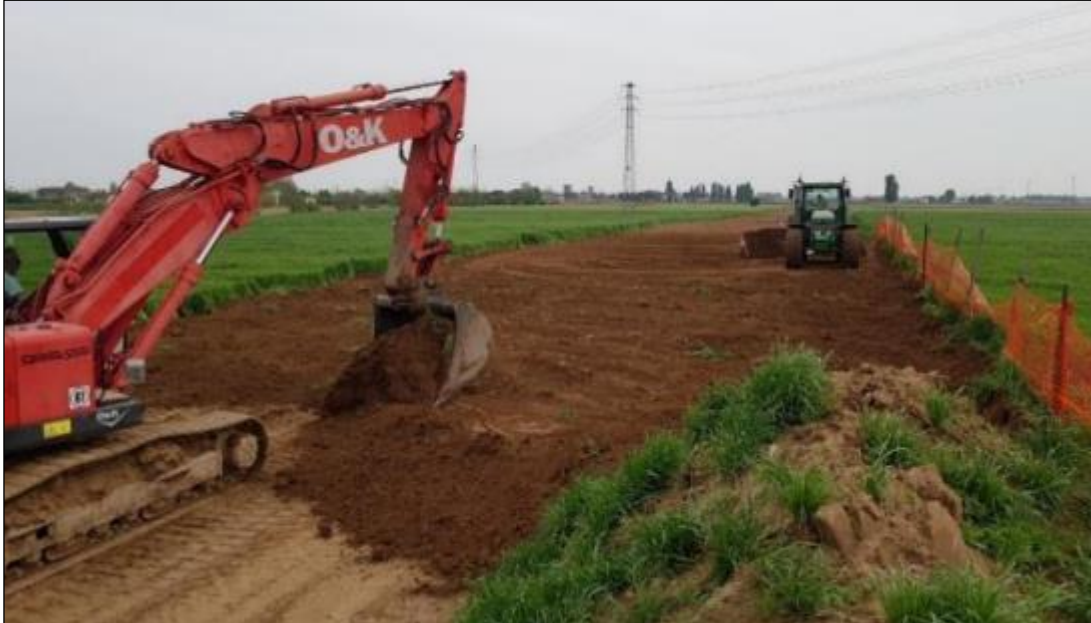
Foto 3.2.1/K Distribuzione dello strato fertile superficiale
