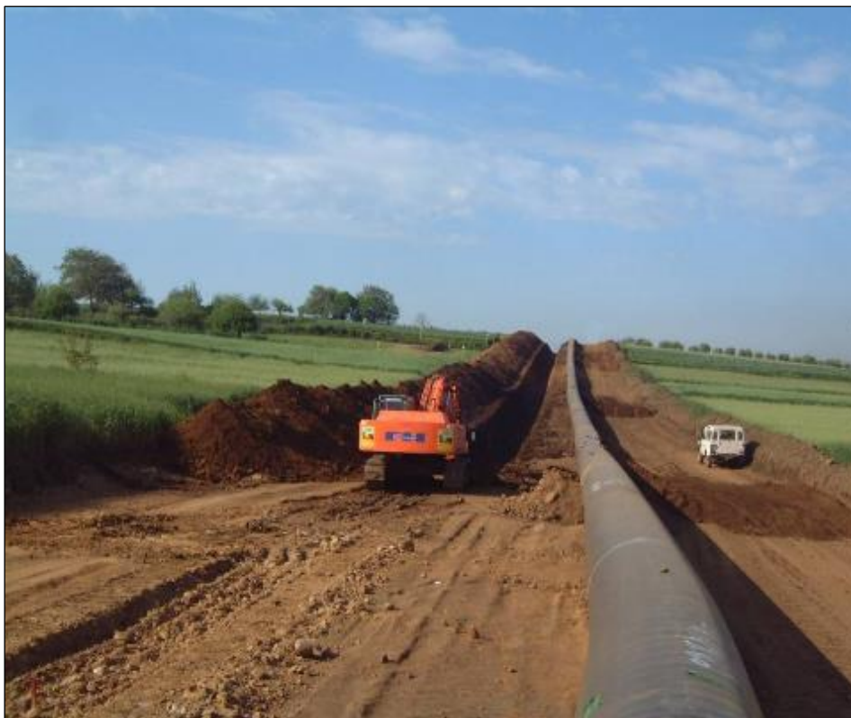
Foto 3.2.1/F Scavo della trincea
