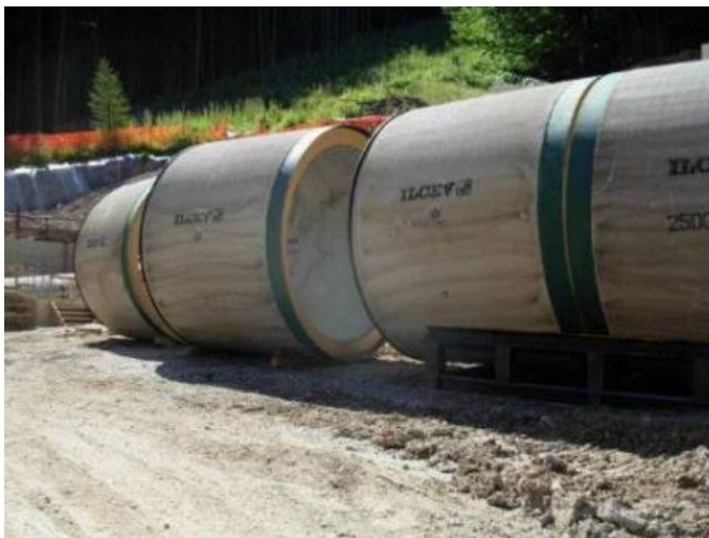
Foto 3.2.2/E Stoccaggio tubi in c.a
