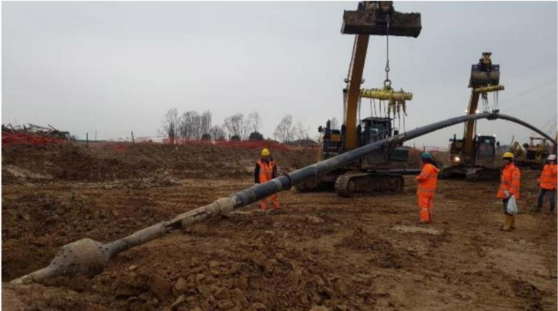
Foto 5/O - Esempio di operazione di varo della TOC
