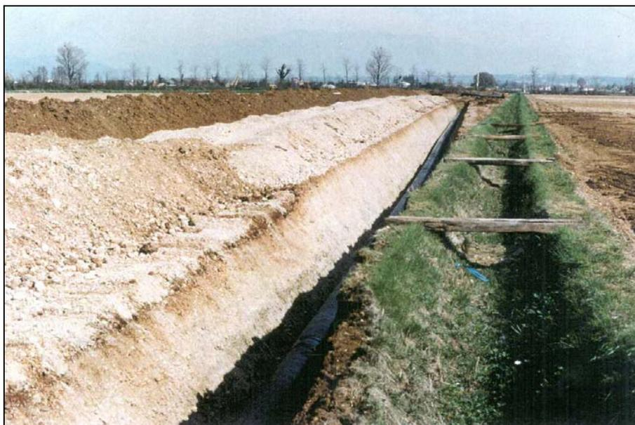
**Foto 5/H - Tratto di condotta posata, si nota l'accantonamento dello strato humico separato dal materiale di scavo della trincea**
