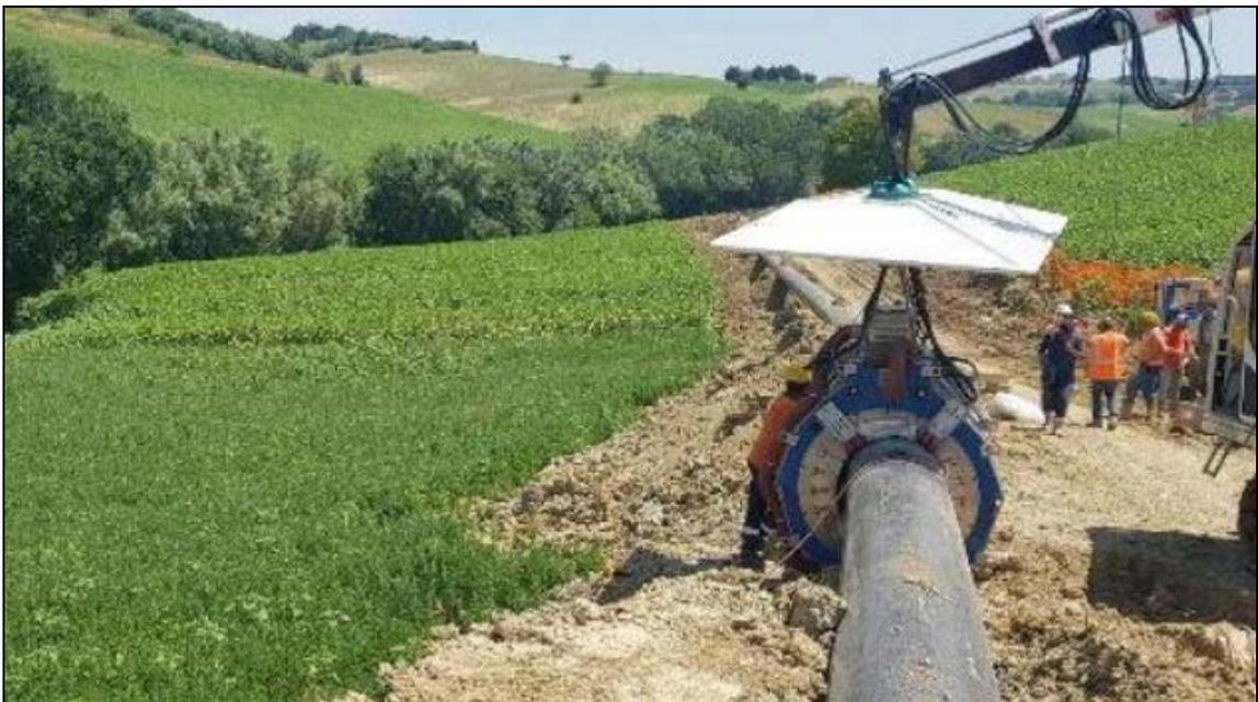
**Foto 5/E - Esempio di saldatura automatica**
