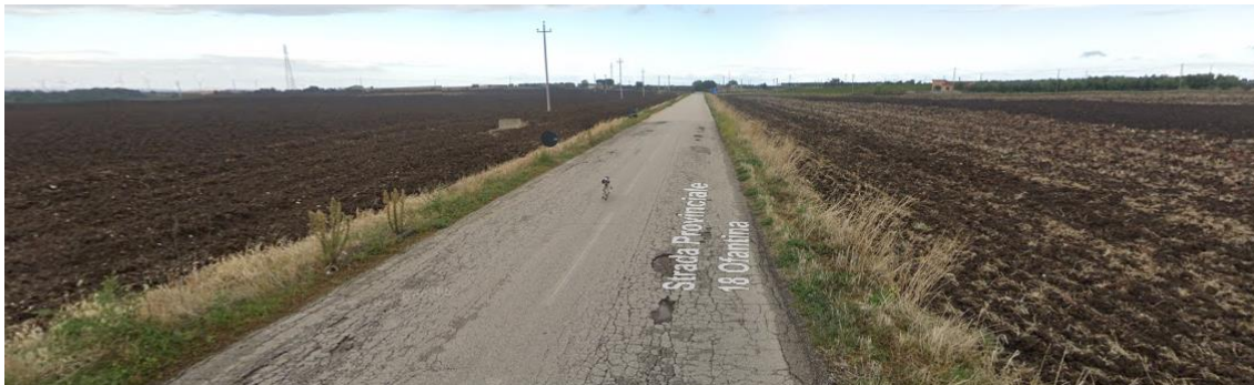
Figura 14: Stato di fatto area 2 – ripresa fotografica da Google
