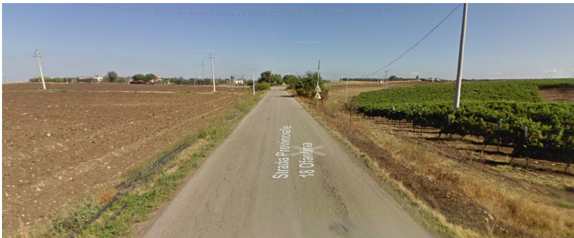
Figura 11: Stato di fatto area 1 – ripresa fotografica da Google
