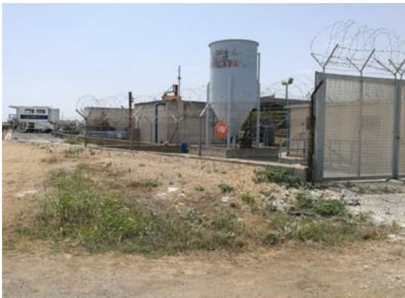
Figura 13 – Impianto di trattamento esistente
