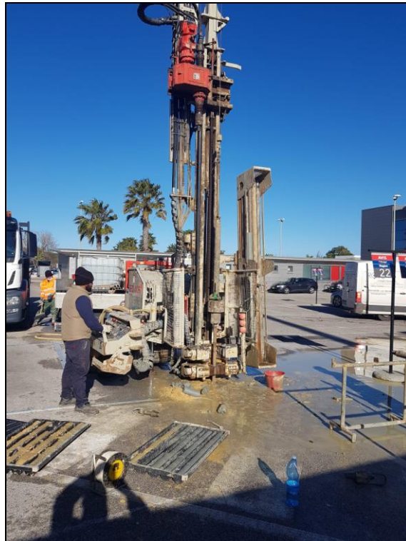
Esecuzione sondaggio geognostico a carotaggio continuo S1
