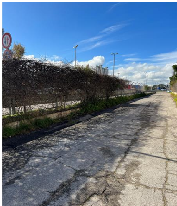
Fig. 25 - Punto di vista fotografico "o"
