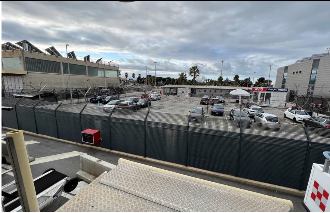
Fig. 3 Foto dell'area di intervento
