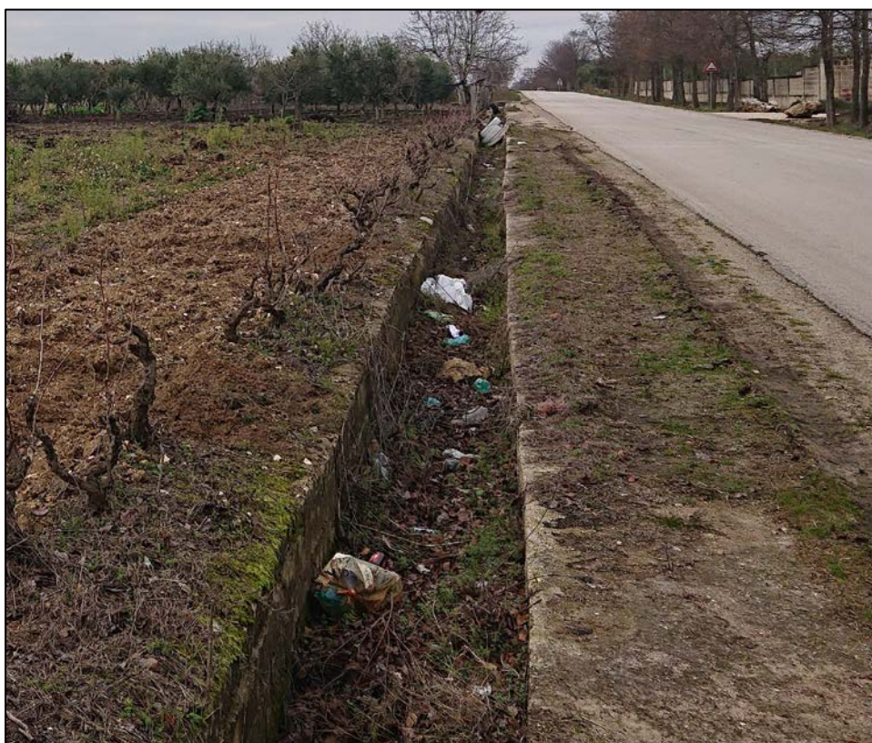
Area di intervento_foto scattata nel dicembre 2020
