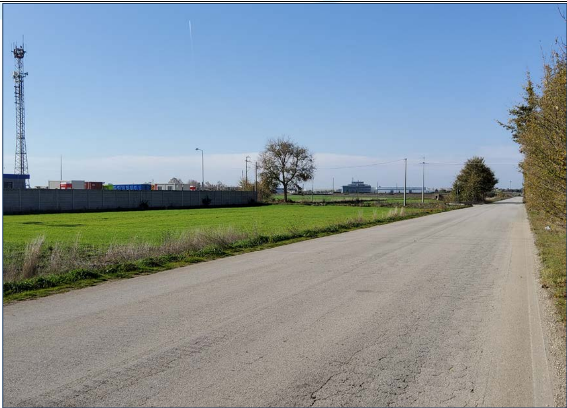
Stazione Terna lungo la SP140 e zona industriale Jesce
