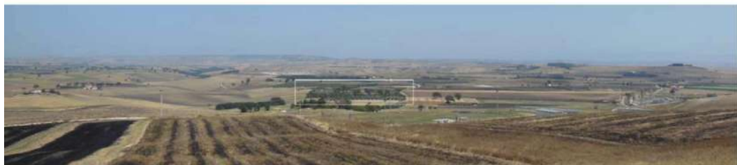
Figura 6-7: Vista di tipo C dell'impianto (Campo fotovoltaico 2) da strada interpodereale: la ridotta distanza
