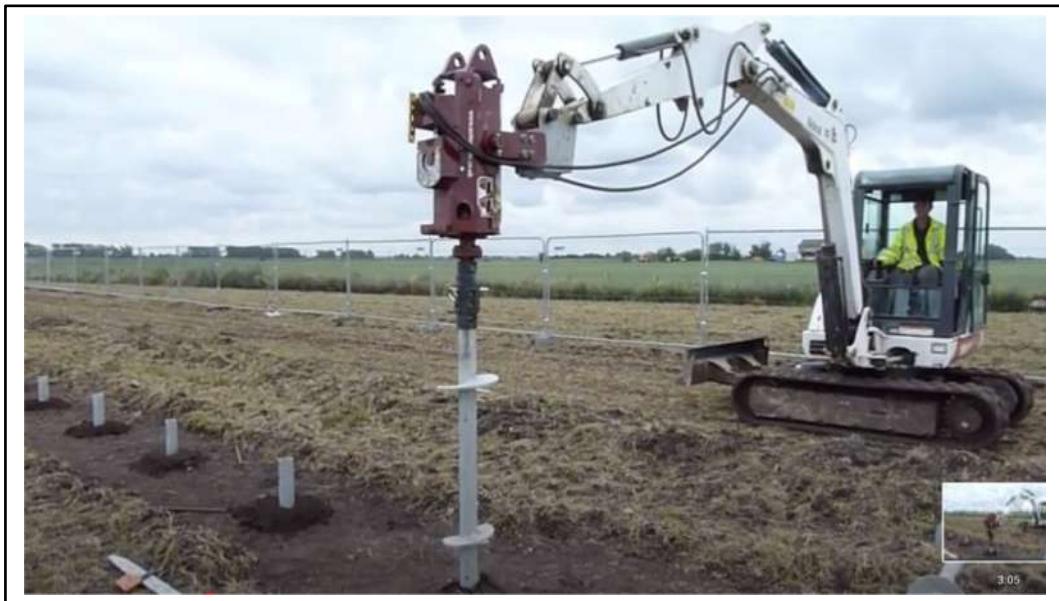
Figura 12-3 Macchina Operatrice per fissaggio supporti strutture
