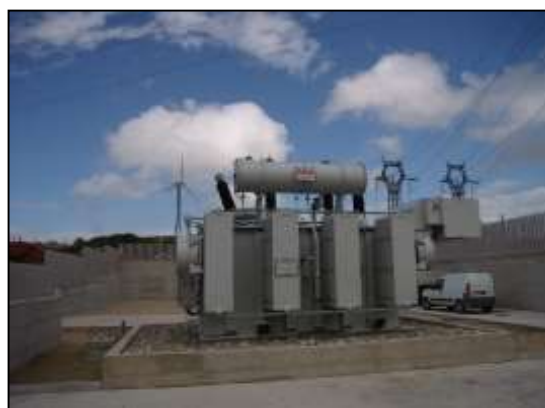
Figura 5-8 Trasformatore MT/AT
