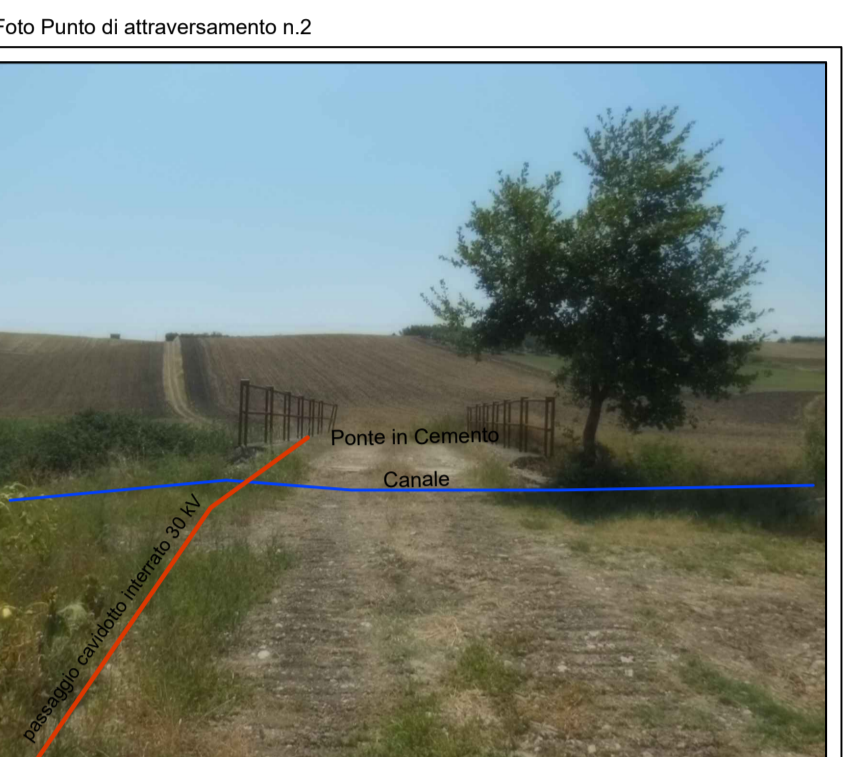
Foto Punto di attraversamento n.2 Attraversamento Canale su ponticello esistente Coordinate: Lat. 41.775009° Long. 15.048306°
