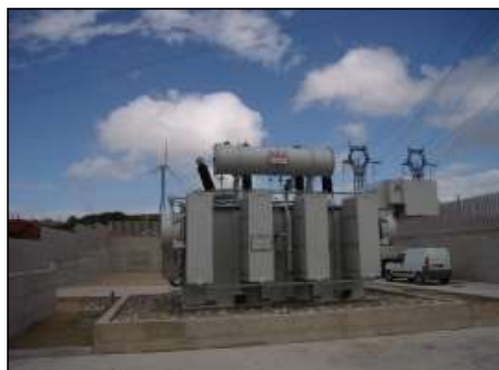
Figura 5-2 Trasformatore MT/AT
