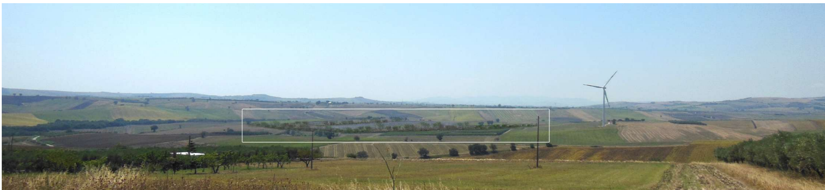
V13-VERIFICA EFFETTUATA CON FOTOINSERIMENTO DALLA S.S.480: L'IMPIANTO È VISIBILE, MA IN GRAN PARTE OSCURATO DAGLI INTERVENTI DI MITIGAZIONE.
