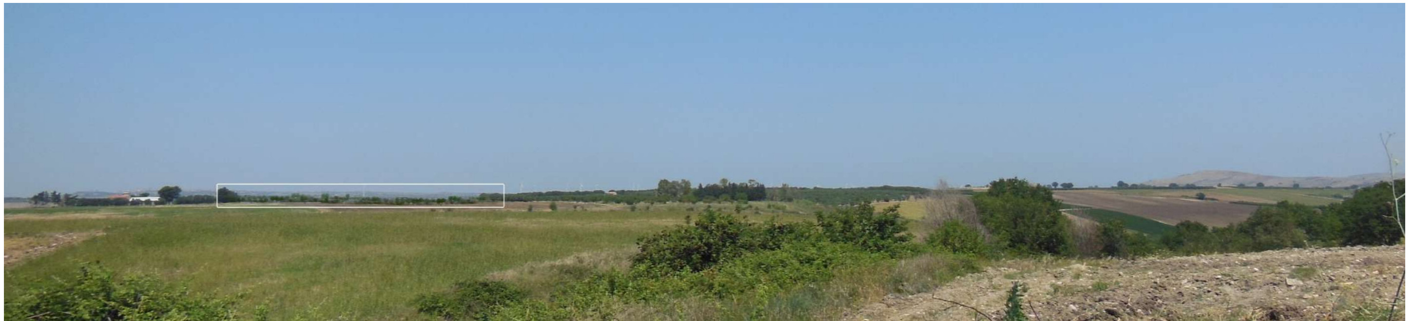
V16-VERIFICA EFFETTUATA DALLA S.P.78: L'IMPIANTO È COMPLETAMENTE MASCHERATO DALLE SIEPI DI MITIGAZIONE VISIVA
