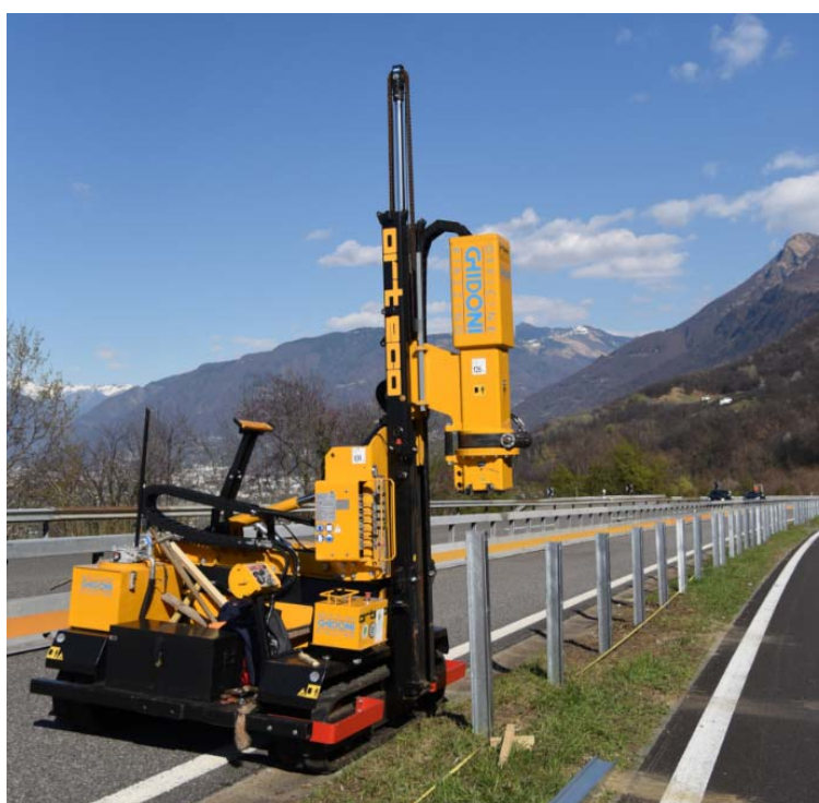
Fig.1 – Esempio di battipalo
