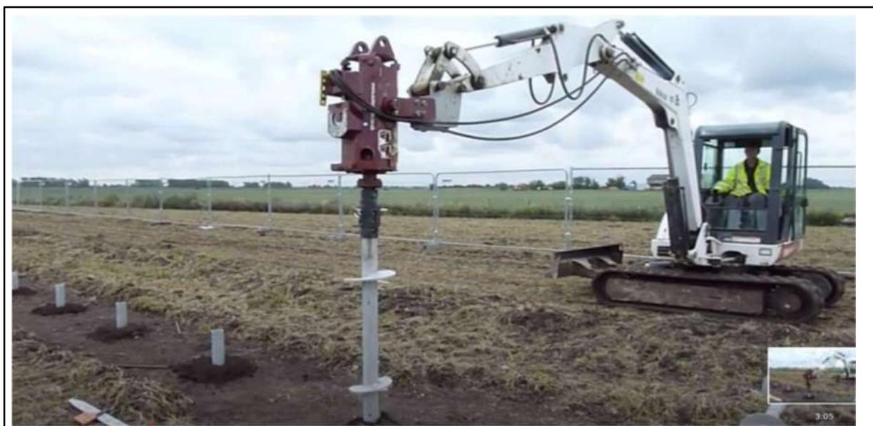
**Figura 12-3 Macchina Operatrice per fissaggio supporti strutture**
