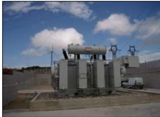
Figura 3-8 Trasformatore MT/AT
