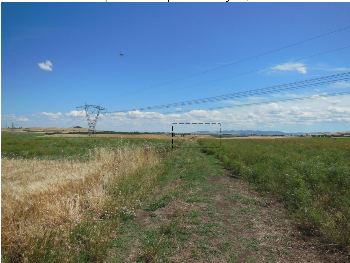
Figura 19: Vista della strada interpodereale che lungo la quale si sviluppa tracciato dell'elettrodotto interrato. Non vi è interferenza con le colture in atto. Nel riquadro l'area della vista della gifura 20.
