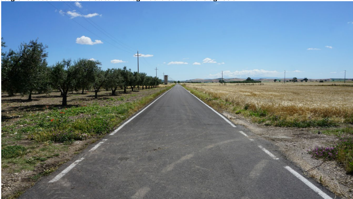
Figura 17: Vista della S.P.78 nel punto esatto in cui l'elettrodotto passa dalla sede stradale alla strada interpodereale posta a sud-est.
