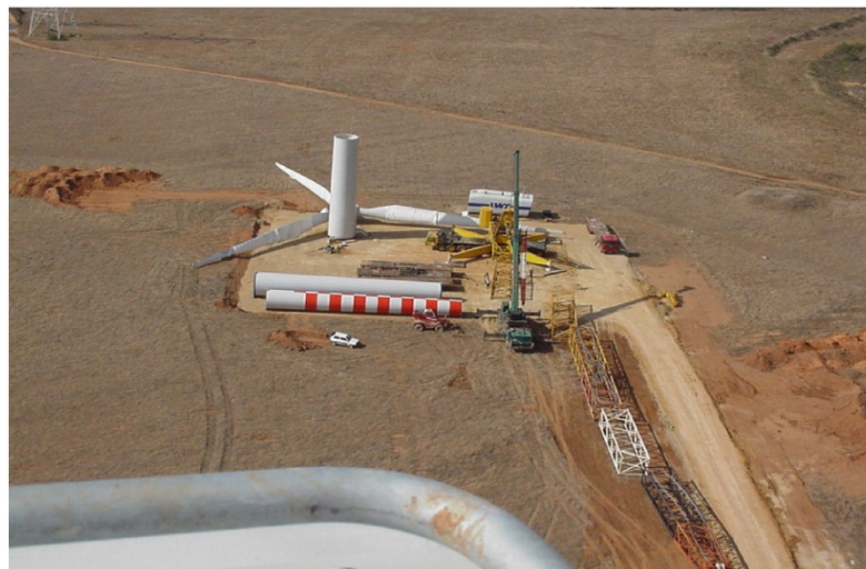
Figura 2 – Piazzola per il montaggio dell'aerogeneratore
