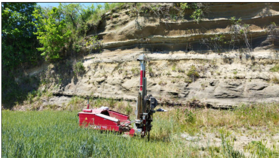
Foto 4: Esecuzione prova penetrometrica DPSH4 sul sito WTG ON04.
