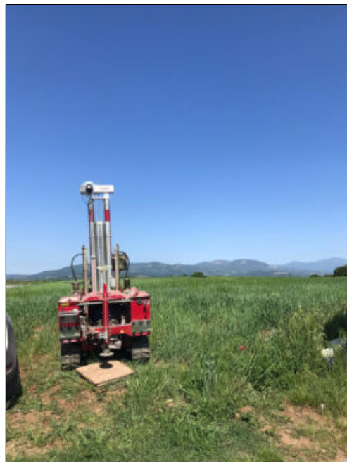
Foto 2: Esecuzione prova penetrometrica DPSH2 sul sito WTG ON01.
