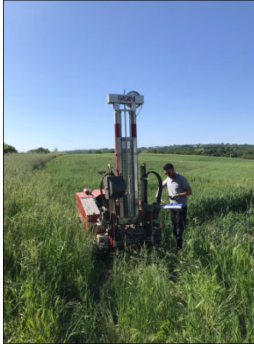
Foto 1: Esecuzione prova penetrometrica DPSH1 nei pressi dei siti WTG ON07 e ON10.
