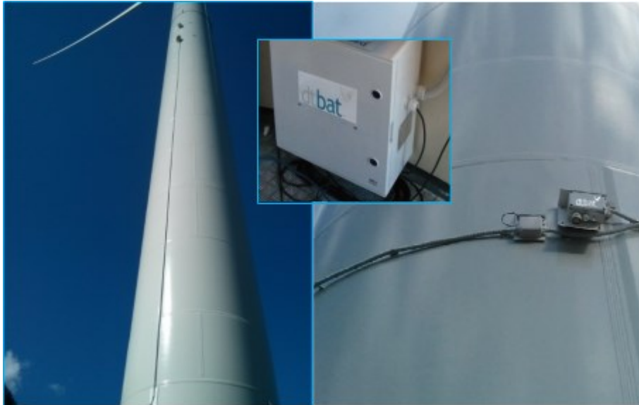
Figura 5 – Esempio di installazione di un sistema automatico su aerogeneratore per abbassare il rischio collisione
