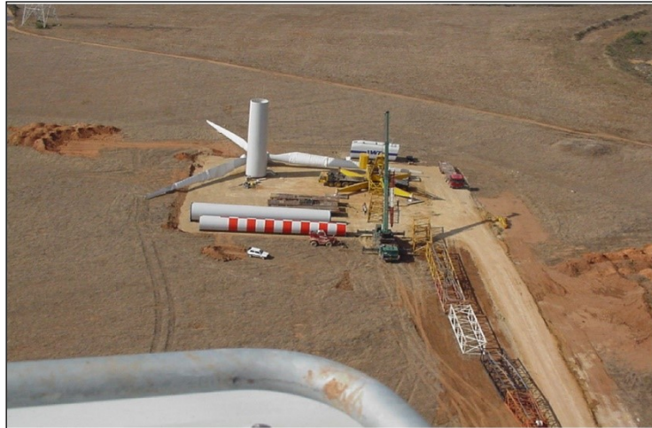
Foto 1. Piazzola per il montaggio dell'aerogeneratore
