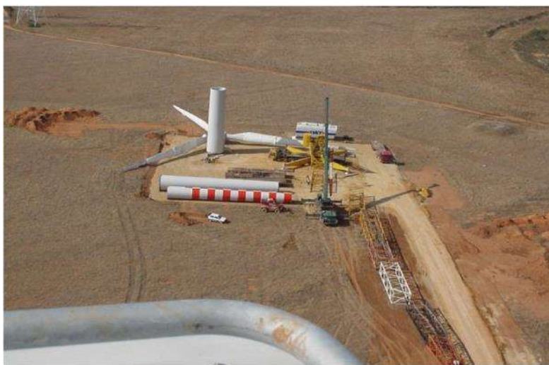
Figura 4 – Piazzola per il montaggio dell'aerogeneratore
