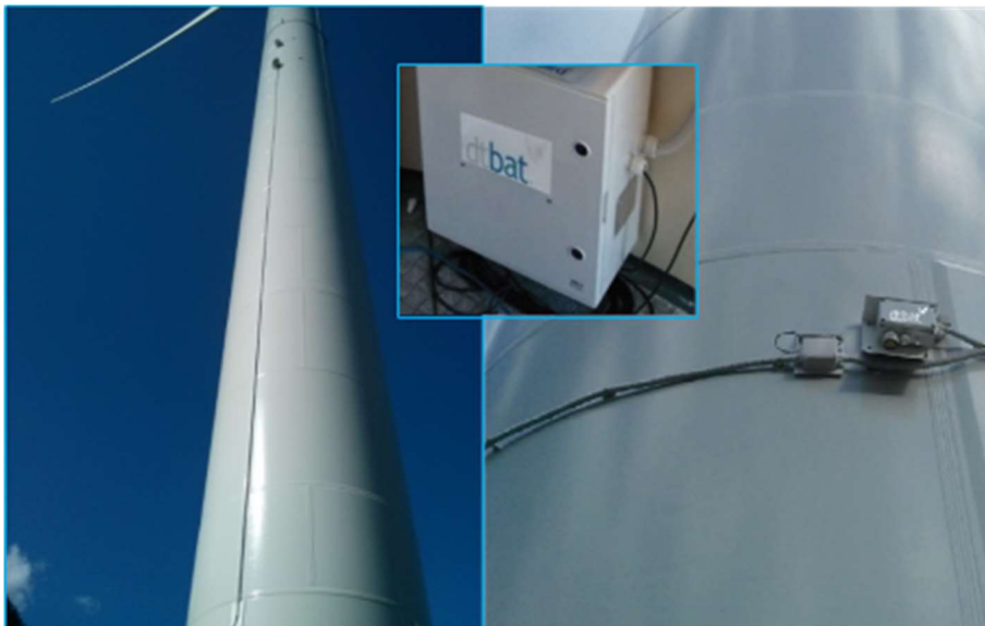
Figura 10 – Esempio di installazione di un sistema automatico su aerogeneratore per abbassare il rischio collisione
