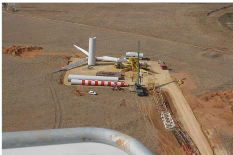
Figura 14 – Piazzola per il montaggio dell'aerogeneratore
