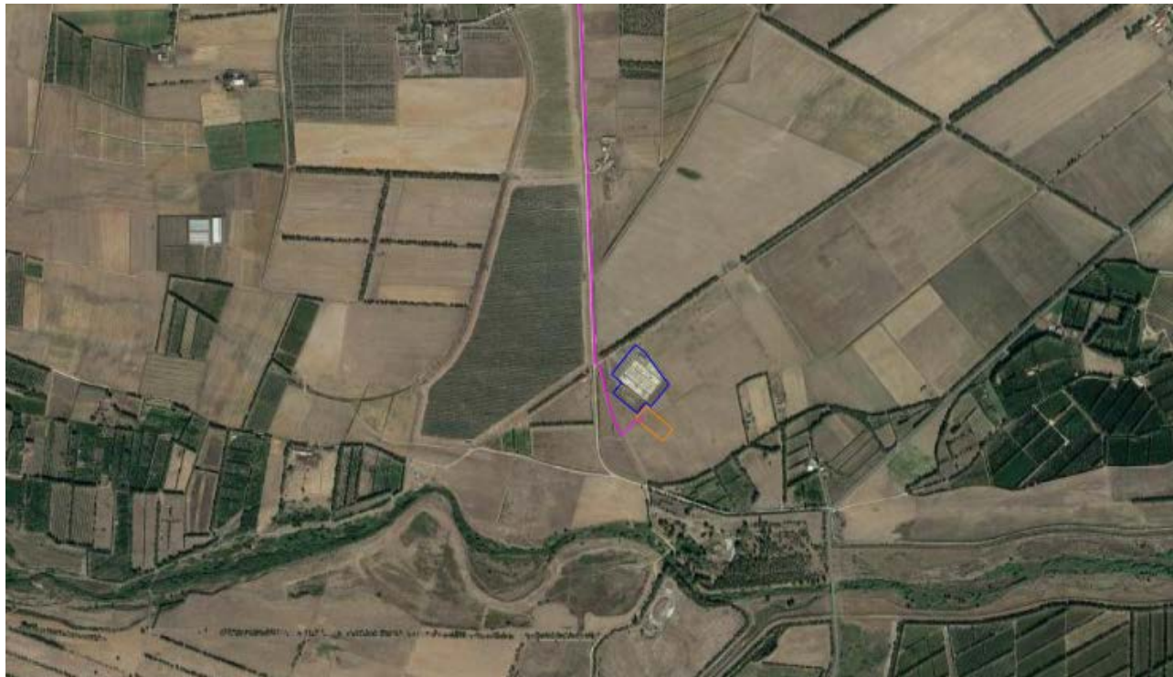
Figura 3: vista aerea dell'impianto della Centrale Terna di Serramanna
