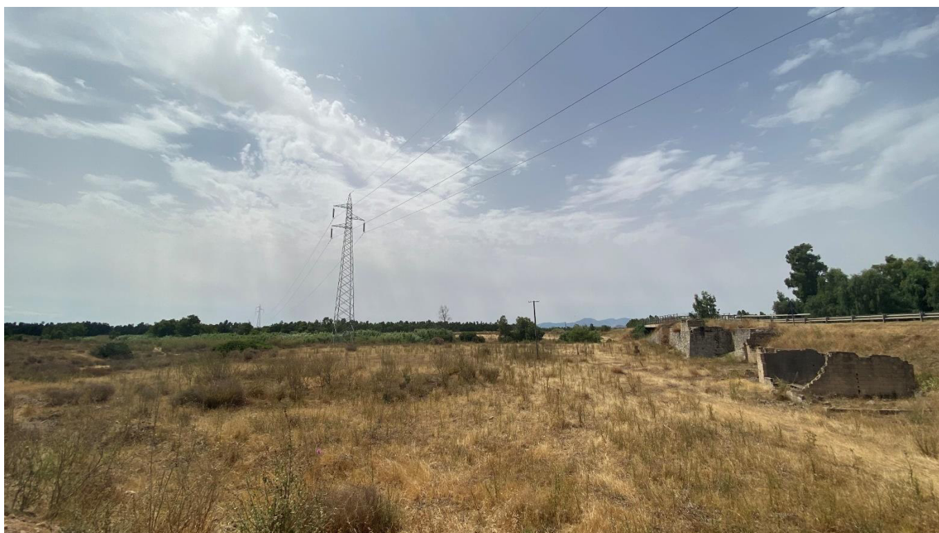
Figura 22 – comune di Serramanna, vista del traliccio n.27 guardando in direzione Sud. Punto dove l'elettrodotto attraversa il Torrente Leni, in prossimità della SS 293 di Giba, visibile nella foto sulla destra.
