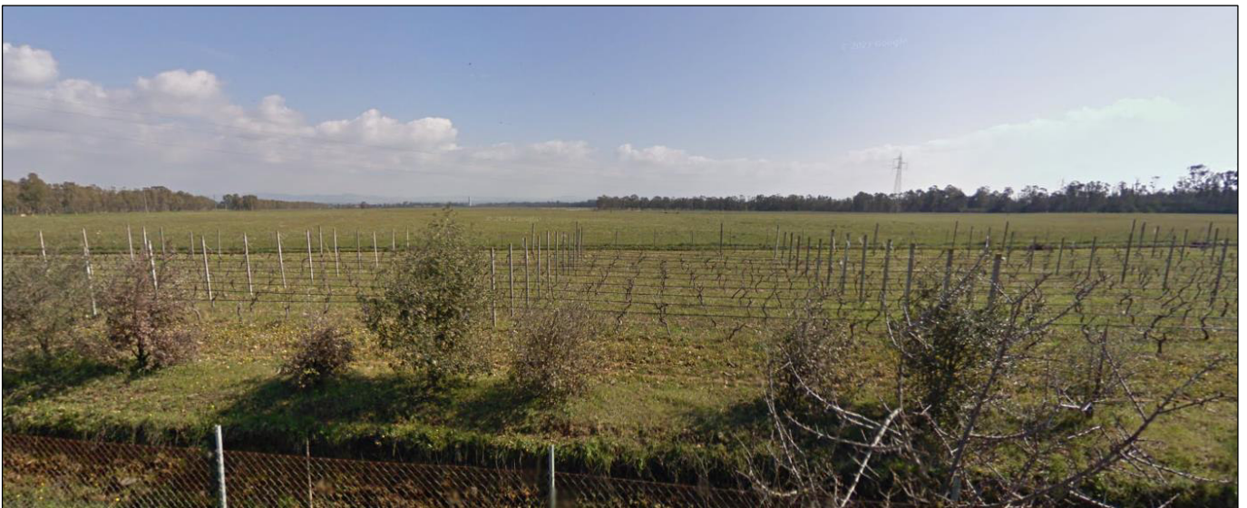
Figura 25 - Panoramica dell'area in cui sorgerà la nuova cabina di trasformazione utente. Ovvero su una parte del prato che si vede oltre i filari di vite (fonte Google Maps).
