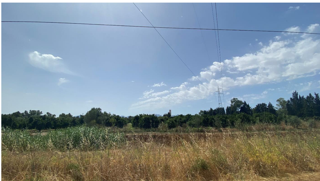
Figura 19 - comune di Serramanna, vita del traliccio n.14 guardando in direzione NO. Da notare in questa come nelle altre foto la presenza costante di siepi alberate e fasce boscate nella zona.
