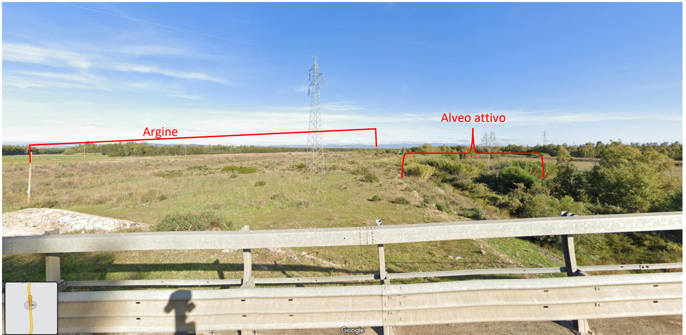
Figura 5 - Panoramica del torrente Leni dal ponte della SS293 (fonte Google Maps).
