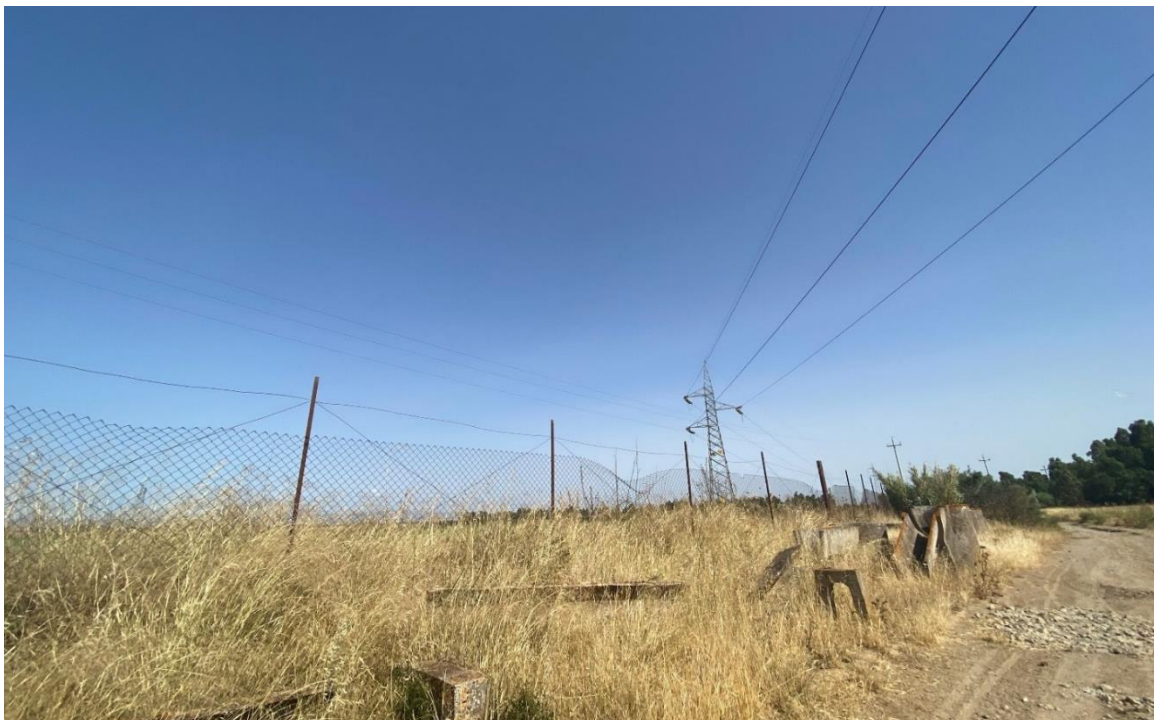
Figura 14 - comune di Serramanna, vista del traliccio n.5 guardando in direzione SE. Si noti la strada sterrata, caratterizzante tutta l'area di progetto in quanto si tratta di zona agricola.
