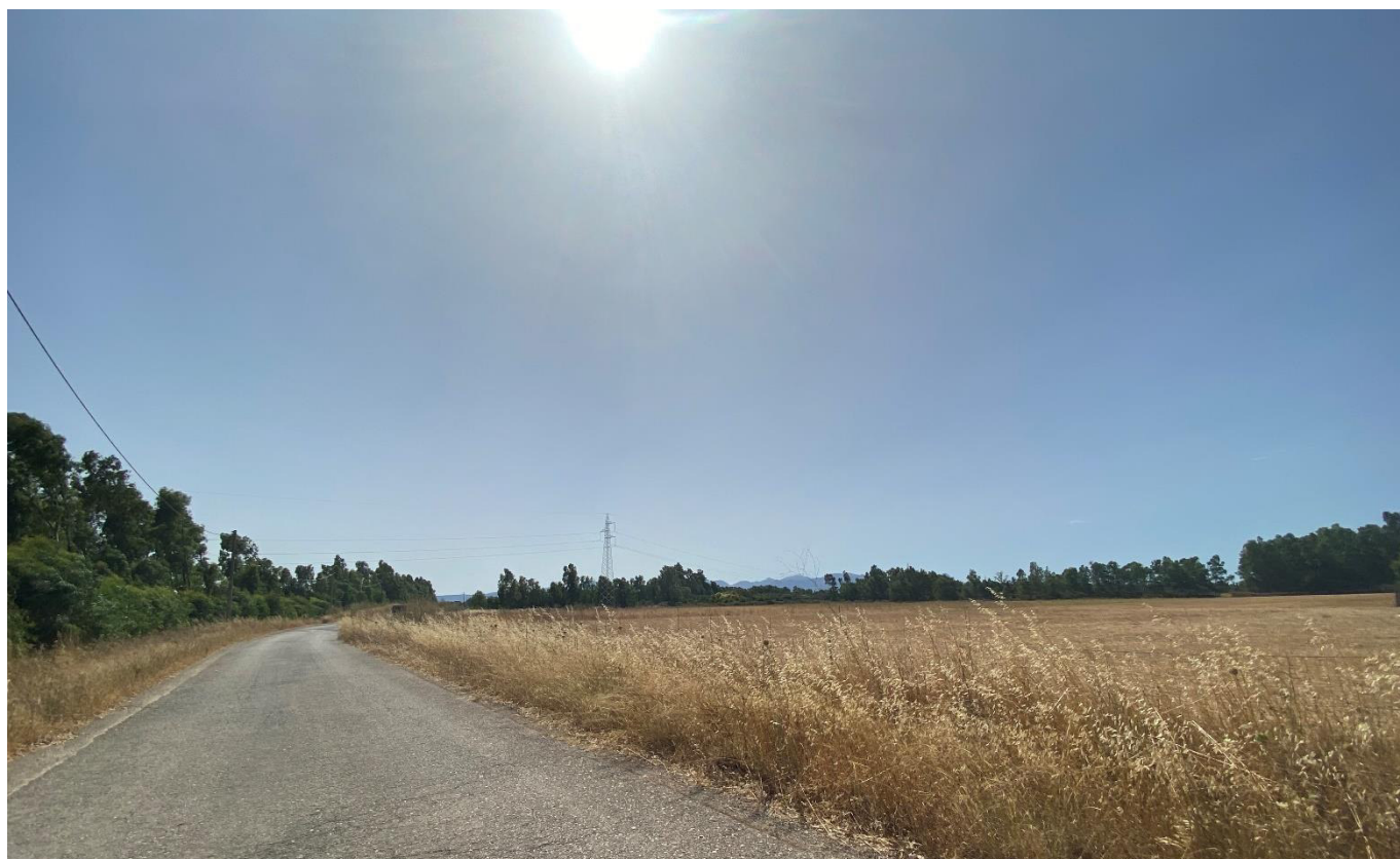
Figura 18 - comune di Serramanna, vista del traliccio n.13 guardando in direzione Ovest.
