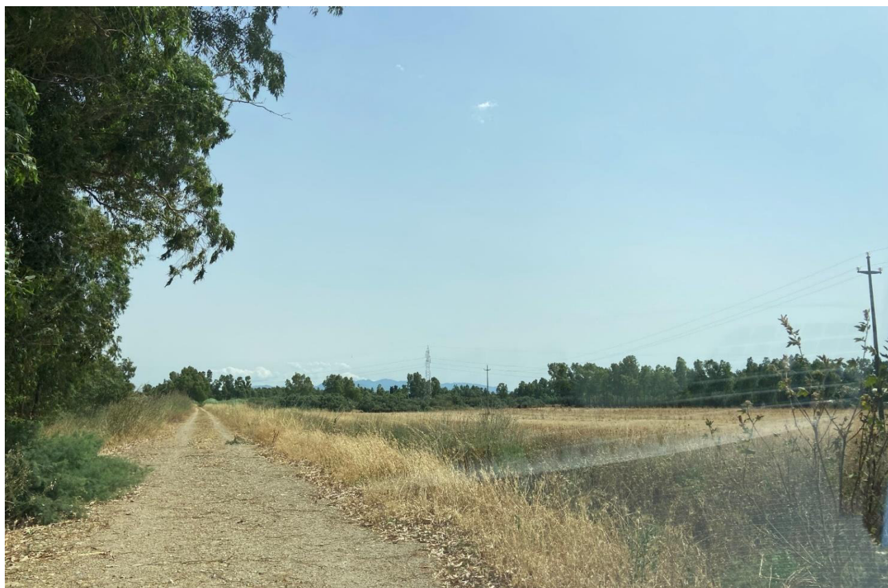
Figura 20 - Comune di Serramanna, vista del traliccio n.15 guardando in direzione SO.
