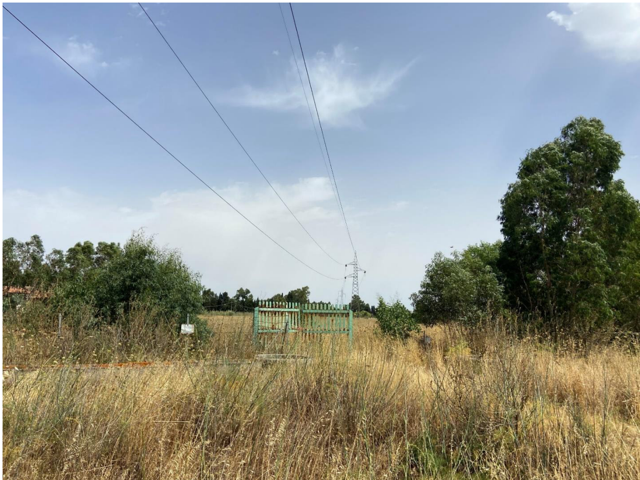
Figura 21 - Comune di Serramanna, vista del traliccio n.19 guardando dal lato stradale in direzione SE.
