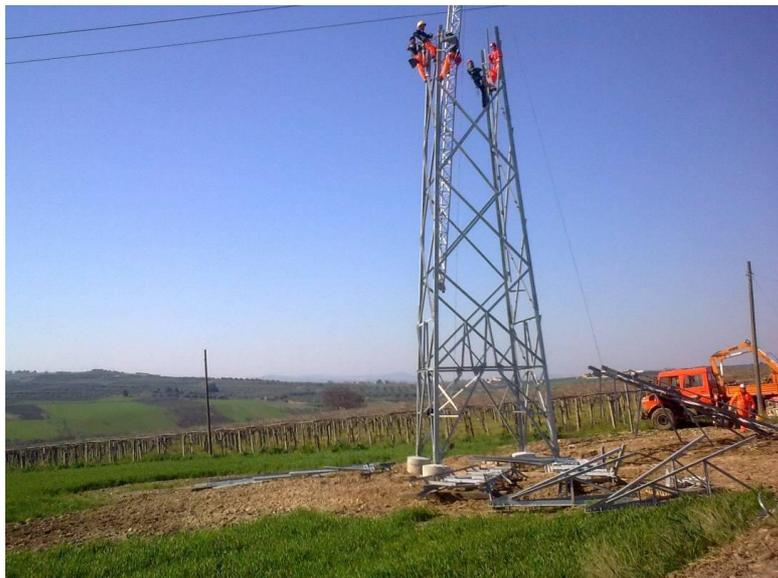
**Figura 8 - Installazione di un sostegno all'interno dei micro cantieri.**
