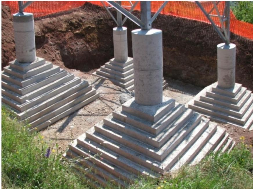
**Figura 9 - Area di micro-cantiere tipo per l'installazione di un sostegno.**
