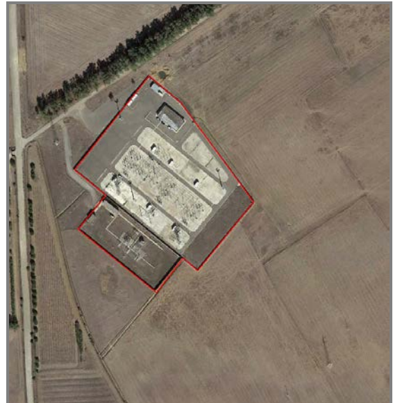
Ortofoto del perimetro della Stazione Elettrica di smistamento di Serramanna in ampliamento.
