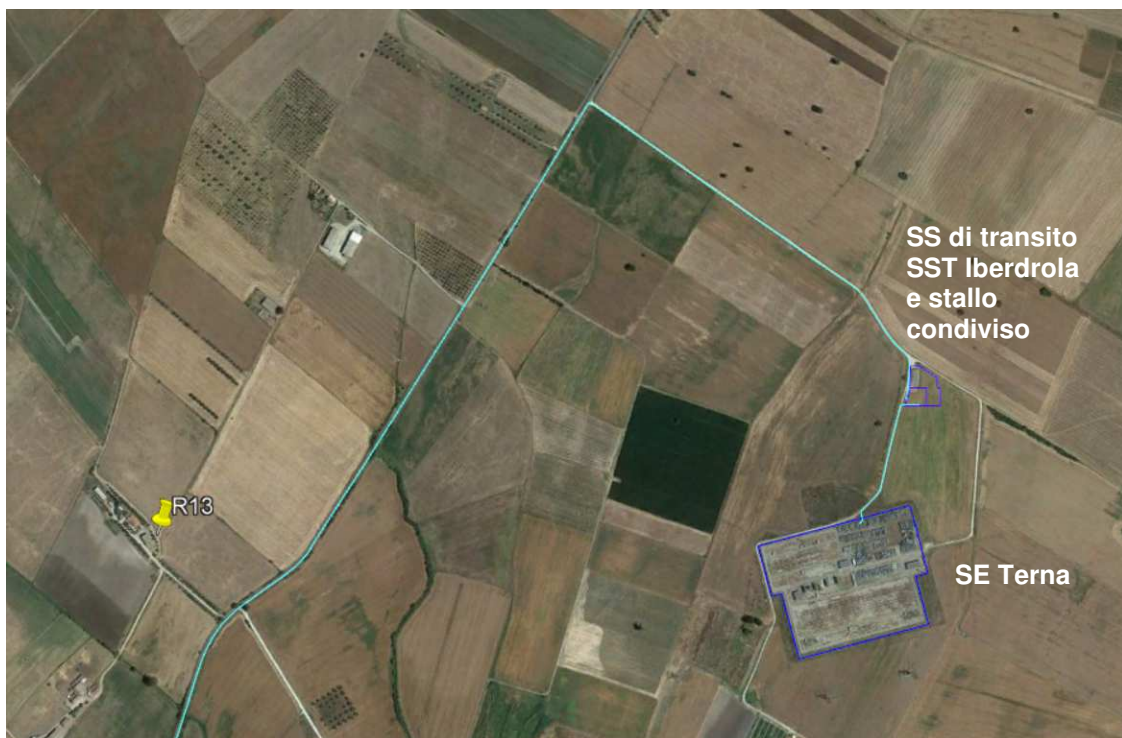
Figura 26. Vista Ricettore, SST Iberdrola e Stazione elettrica Terna.
