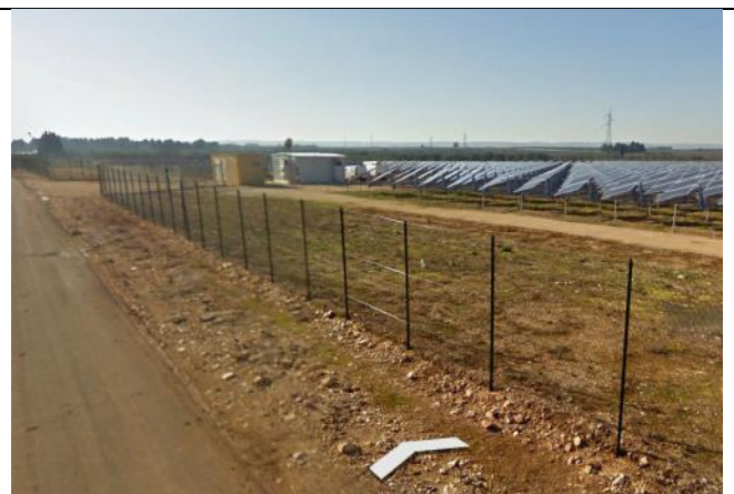
L'impianto è dotato di una recinzione "leggera" in termini paesaggistici, ma è privo di siepe di mitigazione visiva. Sarà comunque visibile solo dai seminativi confinanti.
