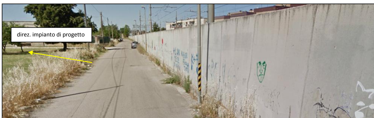
Fig. 2.18: particolare del muro di recinzione del binario ferroviario
